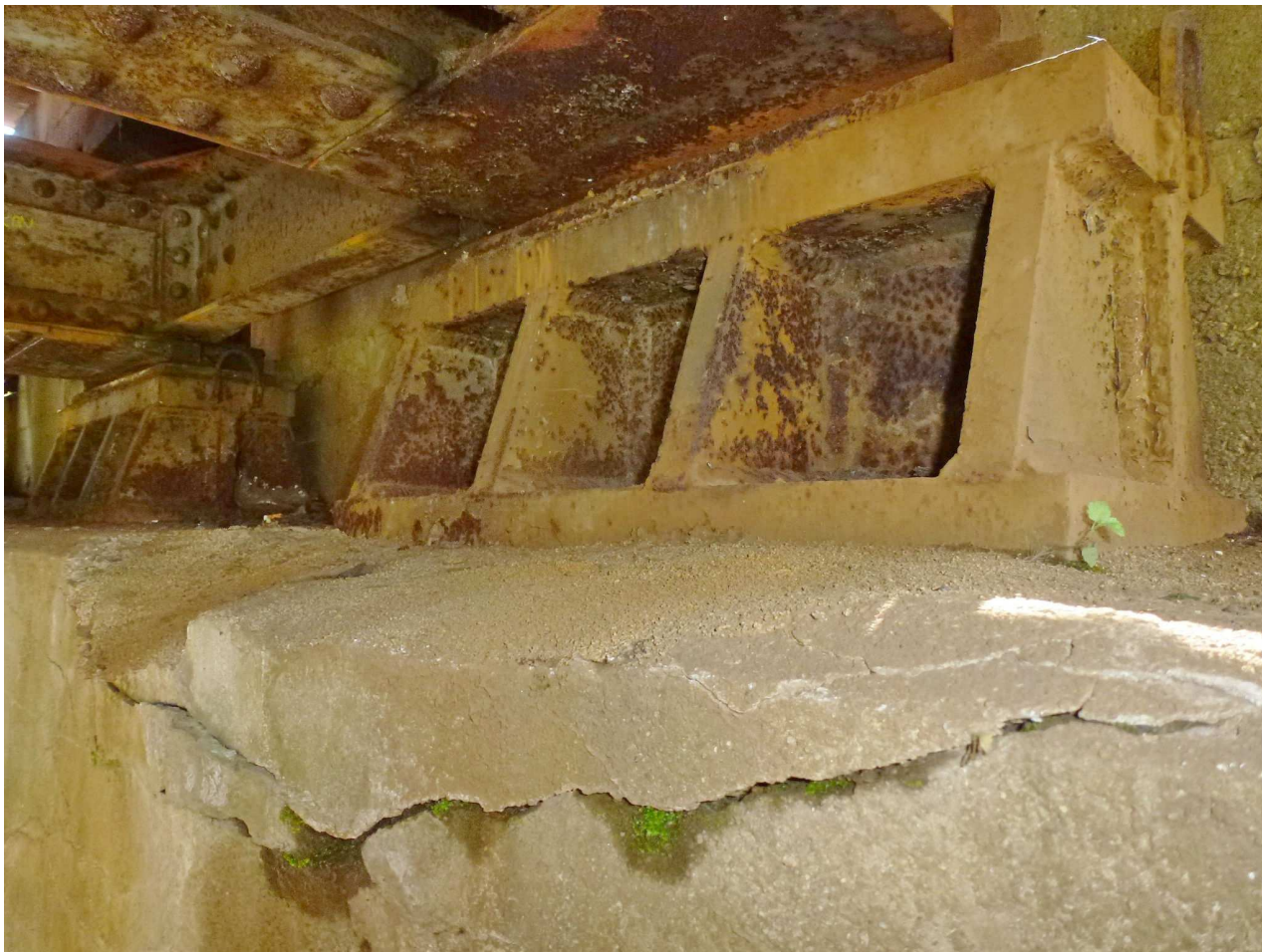
Poškozené ložiskové hnízdo u chebské opěry v koleji č. 2 vpravo
