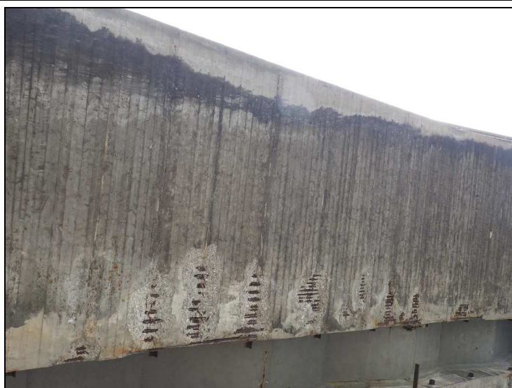
Konstrukce K 25 z pohledu oblouku v části u P 15 v ploše až 1,00 m od hrany na 10 místech degradace betonu → obnažené pruty výztuže
