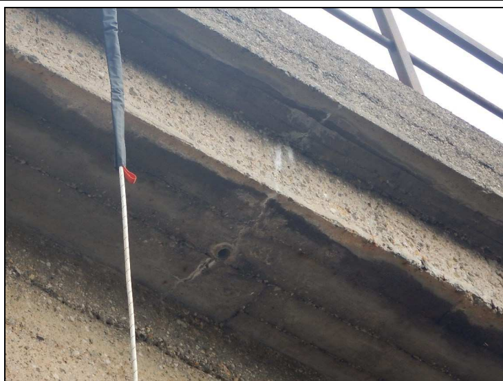
Konstrukce K 011 – římsa vlevo – trhlina s průsaky vody a výluhy pojiva
