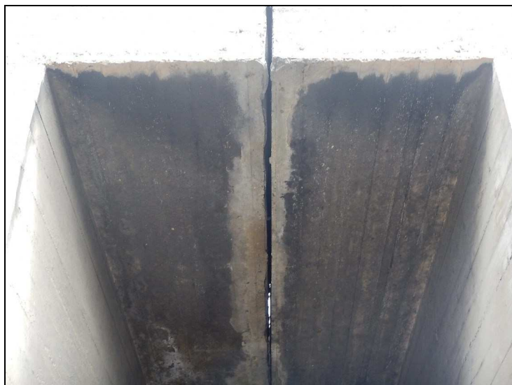
Průsaky vody z dilatační spáry mezi K 11 a K 13
