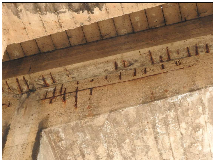
Konstrukce K 02 v otvoru č. 1 – z boční strany desky obnažené pruty výztuže
