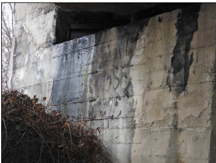
Obr. č. 5 – Opěra O 01 – vpravo v horní části – stékání vody, povrchová degradace betonu
