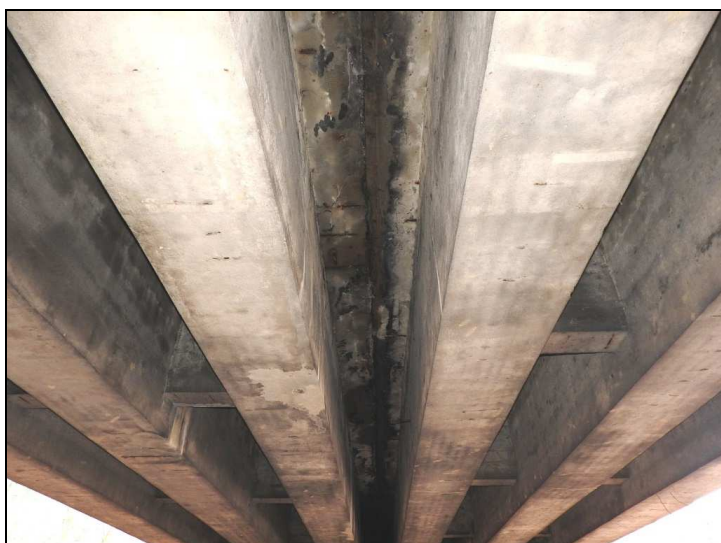
Obr. č. 1 – Konstrukce K 01 – průsaky vody podélnou dilatační spárou
