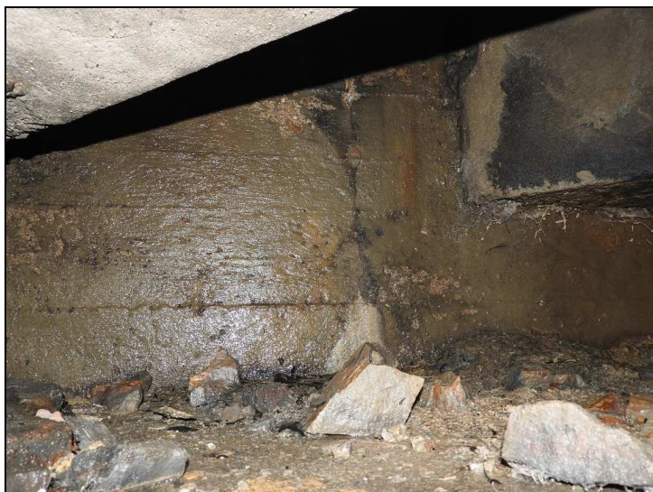
Obr. č. 6 – Opěra O 02 – závěrná zeď – svislá trhlina ve střední části s průsaky vody a výluhy pojiva
