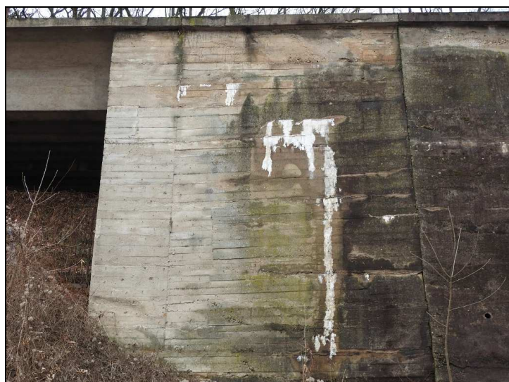
Obr. č. 9 – Opěra O 02 – křídlo vpravo – trhliny s průsaky vody a výluhy pojiva, tvorba krust
