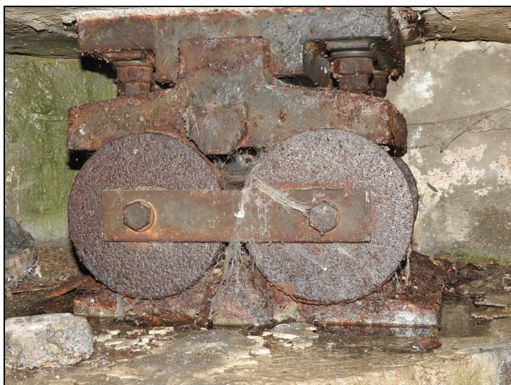
Obr. č. 3 – Konstrukce K 01 – 1. ložisko na O 01 – posun valnice k závěrné zdi, koroze
