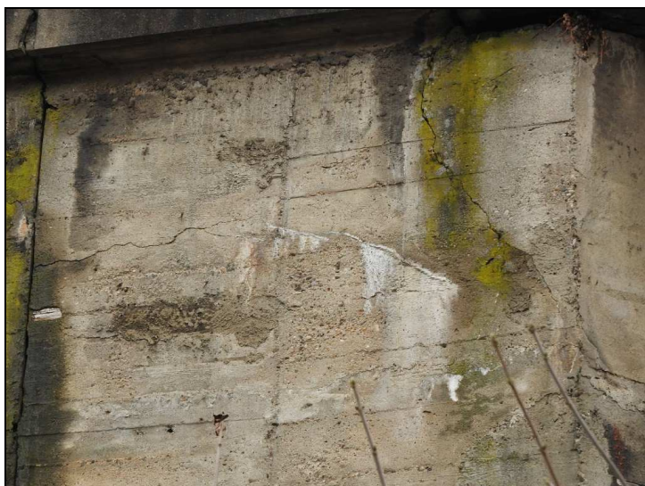
Obr. č. 4 – Opěra O 01 – závěrná zeď vpravo z boční strany – trhliny s průsaky vody a výluhy pojiva
