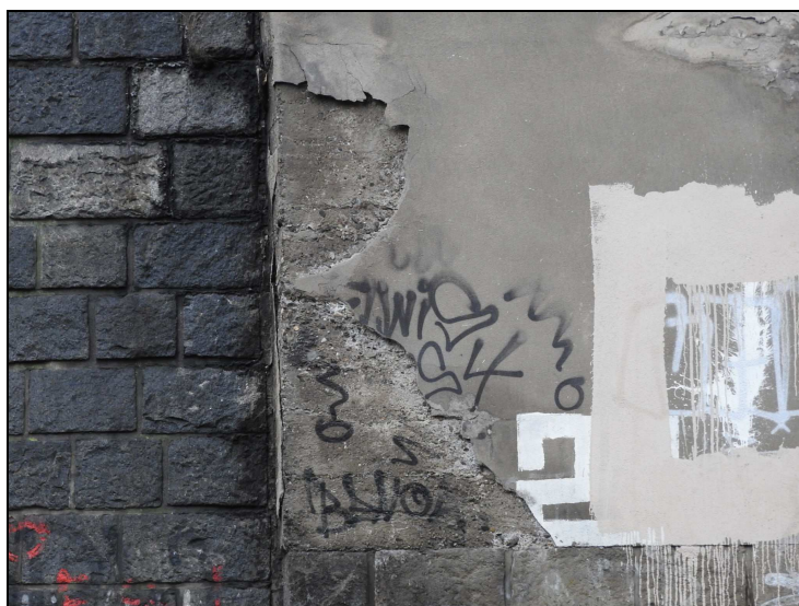
Foto č. 6 – Opěra O 02 – vlevo, degradace povrchu
