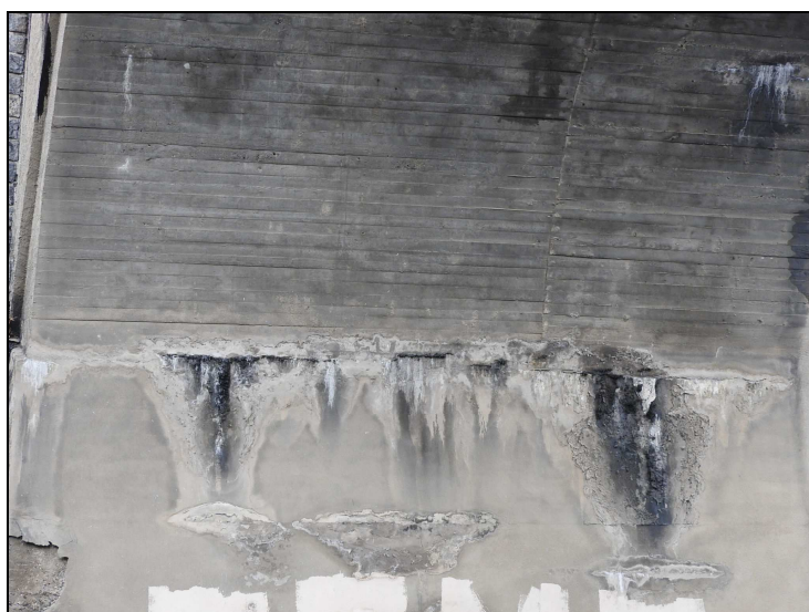
Foto č. 5 – Opěra O 02 – trhlina z NK a průsaky vody s výluhy
