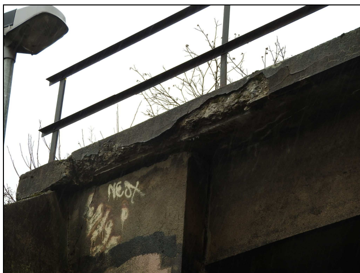
Foto č. 3 – Konstrukce K 01 – římsa vpravo – na začátku zvětralá do hloubky až 50 mm v délce 1,50 m
