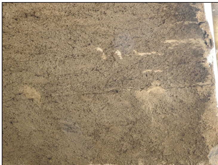
Foto č. 1 – Konstrukce K 01 – vlevo – příčná trhлина
