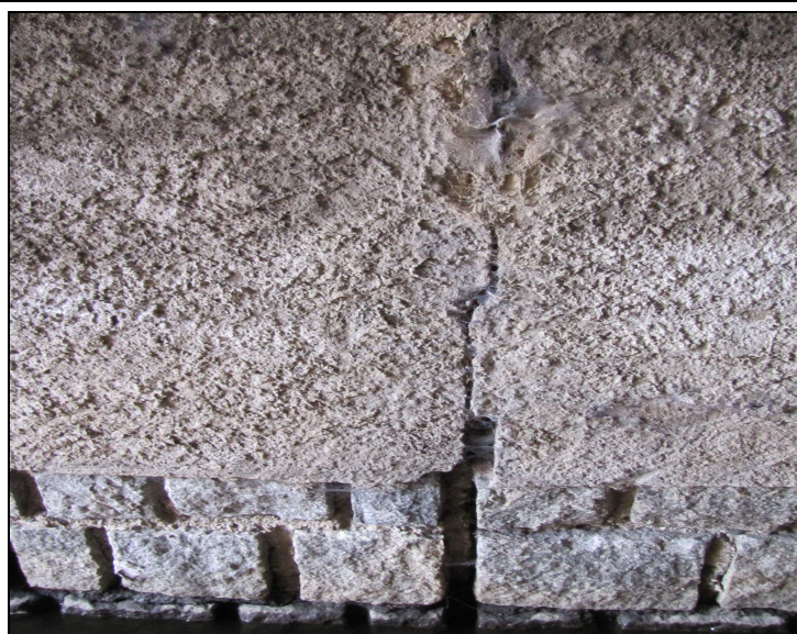
Foto č. 4 – Opěra O 01 – trhlina v podélné dilatační spáře, vyplavené spárování v dolní části
