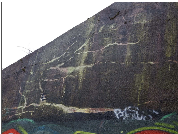
Foto č. 5 – Opěra O 01 – křídlo vpravo – trhliny s výluhy pojiva
