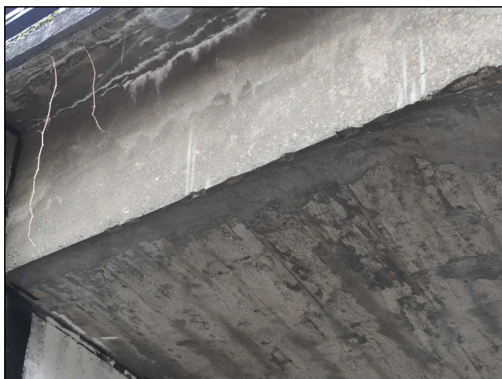
Foto č. 1 – Konstrukce K 01 – dolní hrana vlevo poškozená, s vrypy do hloubky až 30 mm
