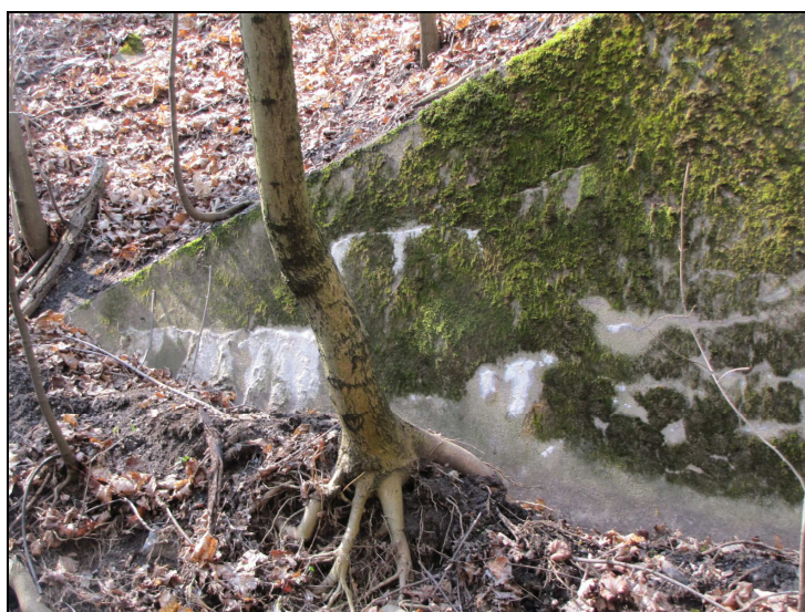
Foto č. 6 – Opěra O 02 – křídlo vlevo – trhliny s průsaky vody a výluhy pojiva
