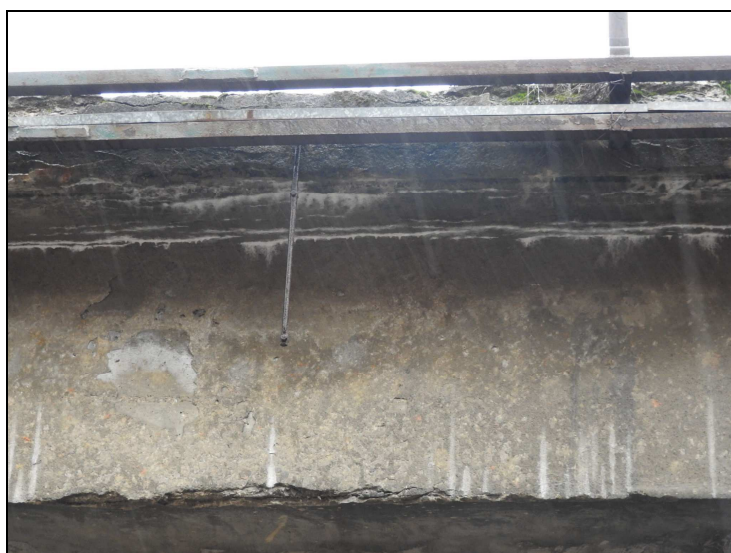
Foto č. 2 – Konstrukce K 01 – římsa vlevo – trhliny s průsaky vody a výluhy pojiva
