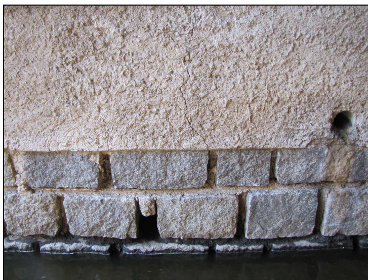
Foto č. 5 – Opěra O 02 – vlevo – svislá trhlina přecházející do klenby
