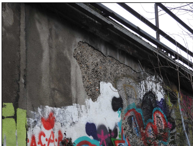
Foto č. 4 – Opěra O 01 – vlevo v horní části průsaky vody s výluhy pojiva, vzduť omítka, zvětralý beton římsy
