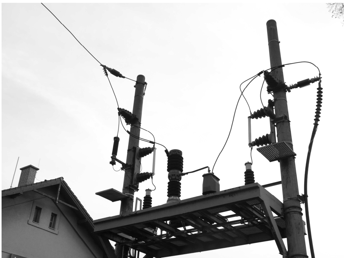
Obr. 3 - Přístrojové vybavení vn stávající stožárové SpS 25 kV-AC v žst. Lužany
