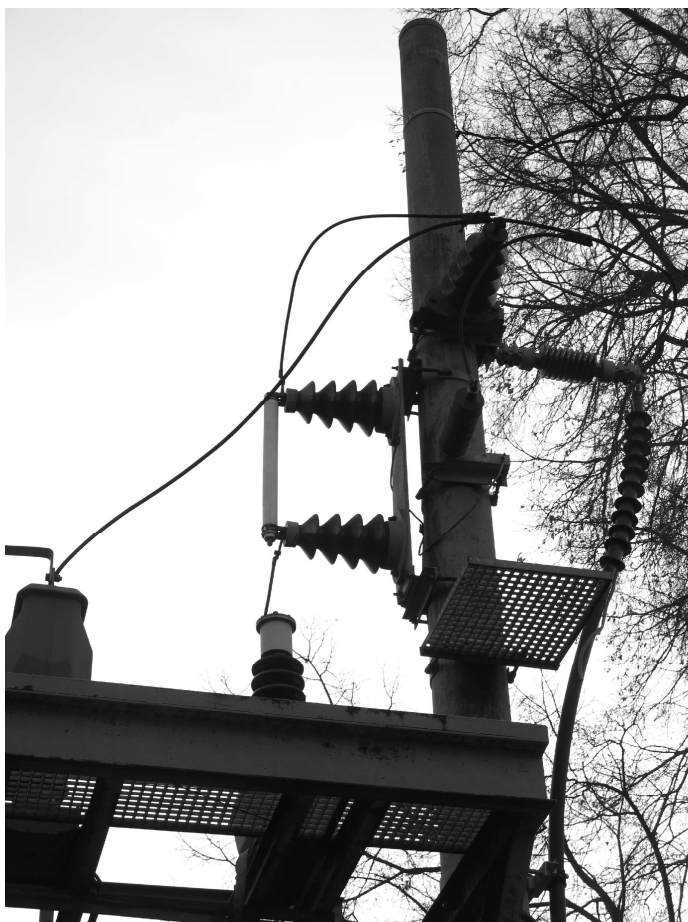
Obr. 5 - Přístrojové vybavení vn stávající stožárové SpS 25 kV-AC v žst. Lužany - detail kabelového svodu s omezovačem přepětí a pojistky s PTN
