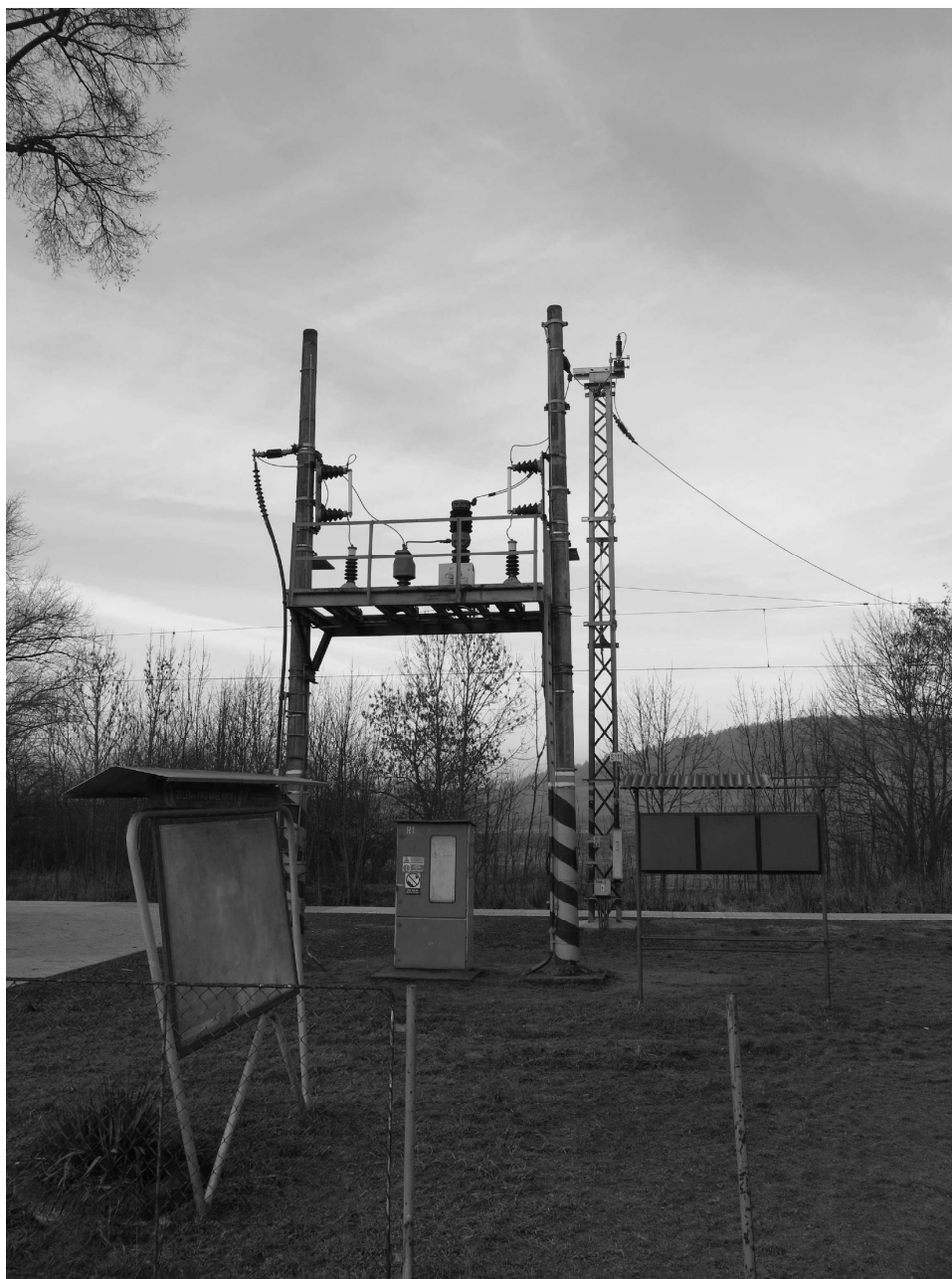
Obr. 1 - Stávající stožárová SpS 25 kV-AC Lužany - celkový čelní pohled od trati
