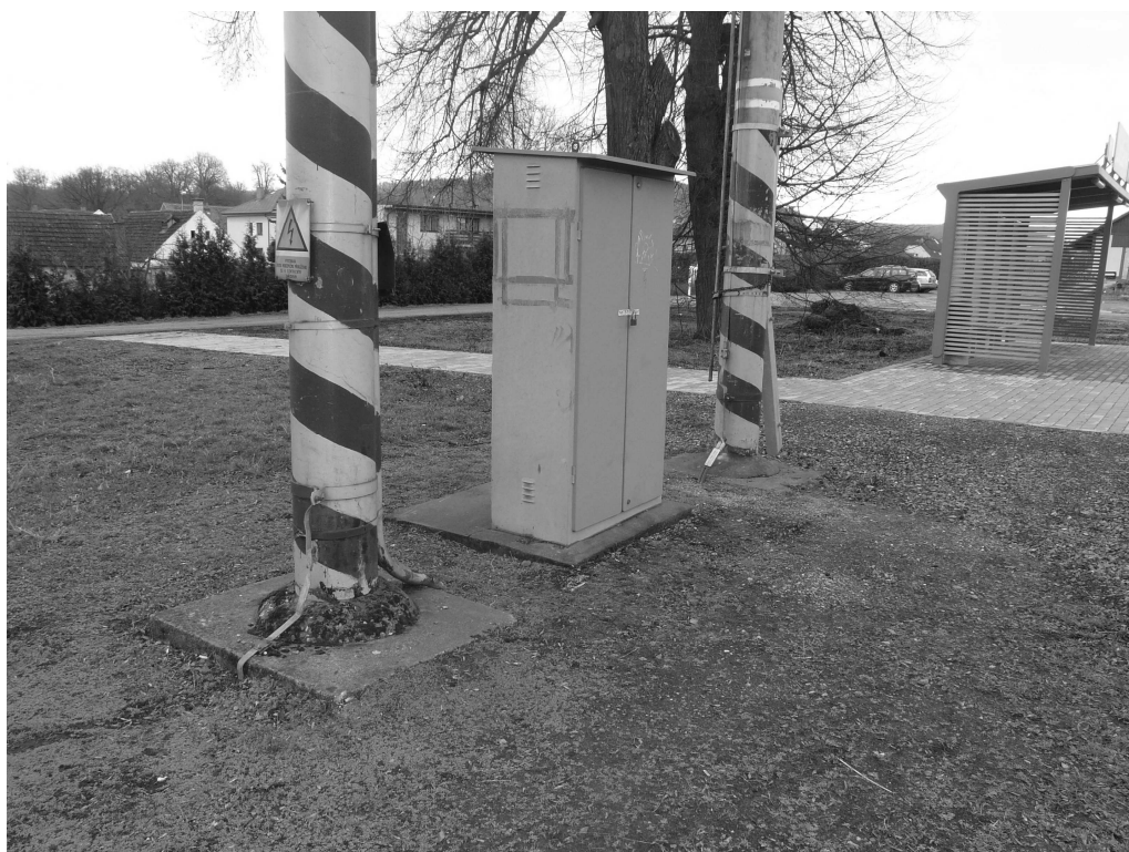
Obr.7 – Ovládací skříň SpS Lužany 25 kV-AC – zadní strana směrem ke koleji žst. Lužany
