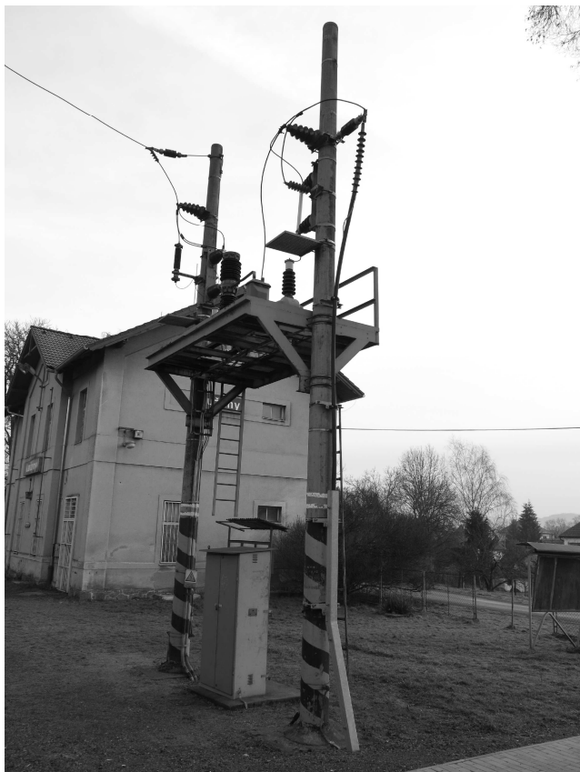
Obr. 2 - Stávající stožárová SpS 25 kV-AC Lužany - celkový boční pohled
