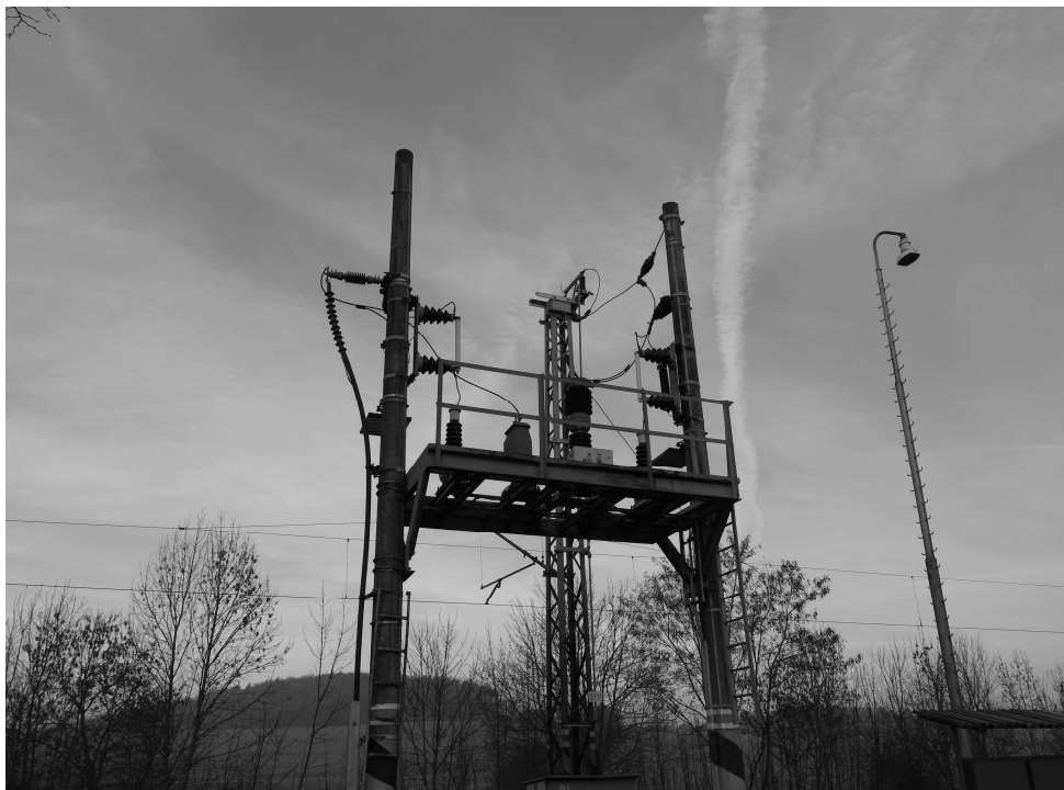
Obr. 4 - Přístrojové vybavení vn stávající stožárové SpS 25 kV-AC v žst. Lužany
