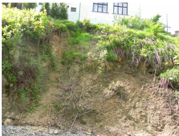
Sesuv zcela zvětralých hornin ve stěně zářezu
