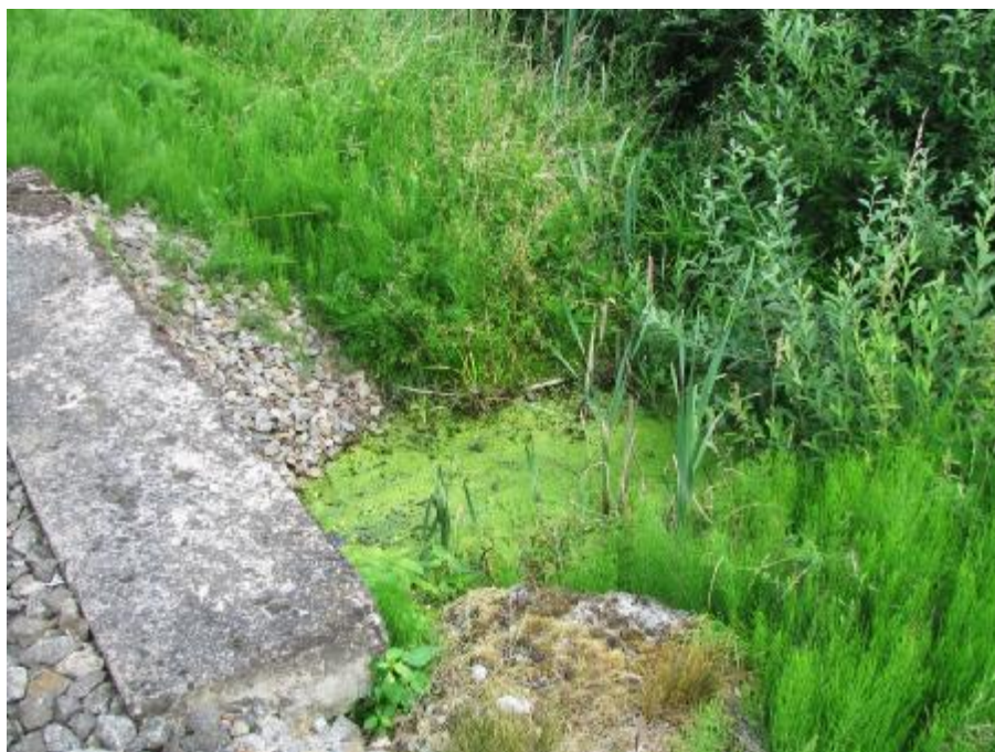
Pohled na odvodňovací příkop a část propustku (hladina vody -1,2m pod úložnou plochou pražců)
