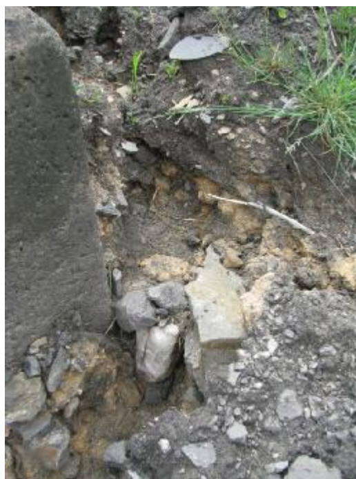
eroze v jejímž důsledku dochází k obnažování základových patek výstražných křížů žel. přejezdu
