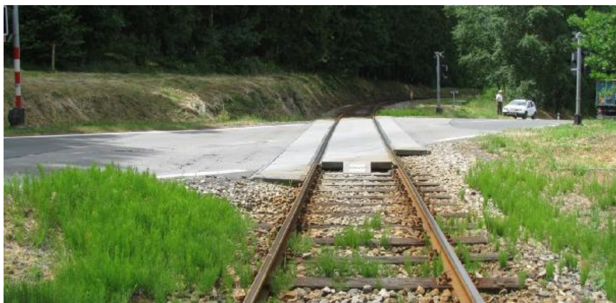
žel. přejezd je veden v nízkém jednostranné odřezu
