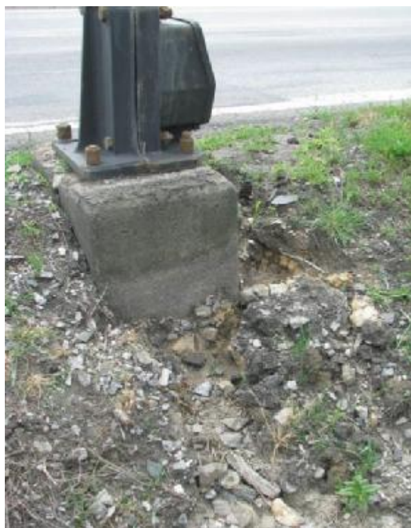
eroze v jejímž důsledku dochází k obnažování základových patek výstražných křížů žel. přejezdu
