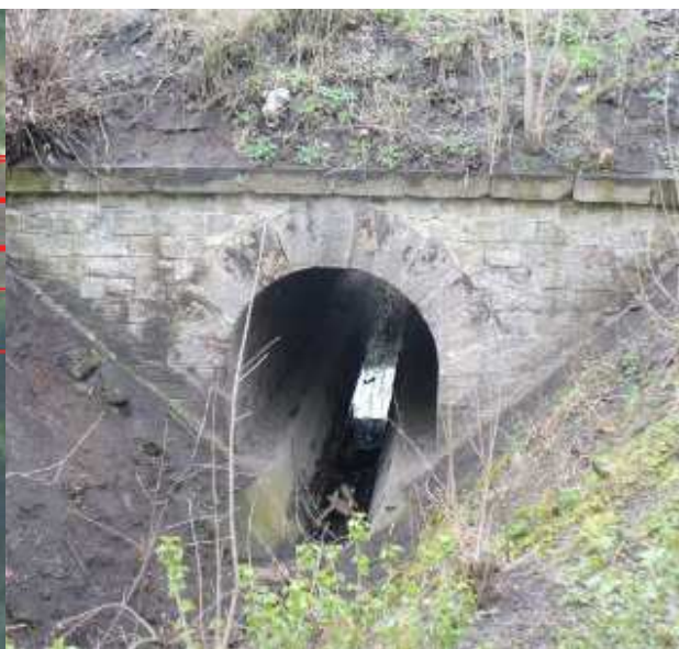
Obr. 13 SO 06-21-06 Mstětice - Praha Horní Počernice, propustek v ev. km 18,780, dotčené území Horní Počernice, stávající stav: vlevo kamenná klenba sv. 2,0 m, vpravo deska ze zabetonovaných kolejnic sv. 2,0 m
