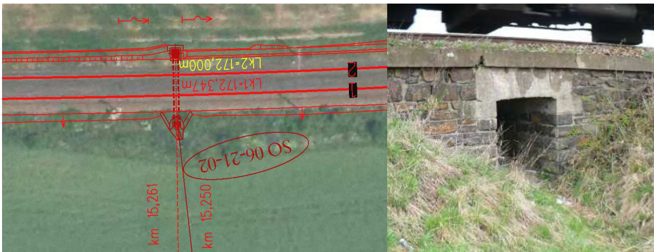
Obr. 10 SO 06-21-02, dotčené území Mstětice, stávající stav: deskový propustek sv. 1,0m, kamenná sp. st.
