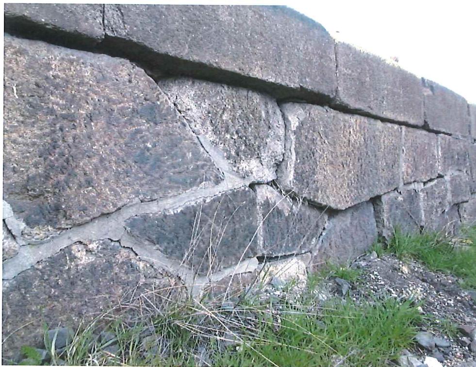
Obr. č. 2 – uvolněné a deformované zdivo
