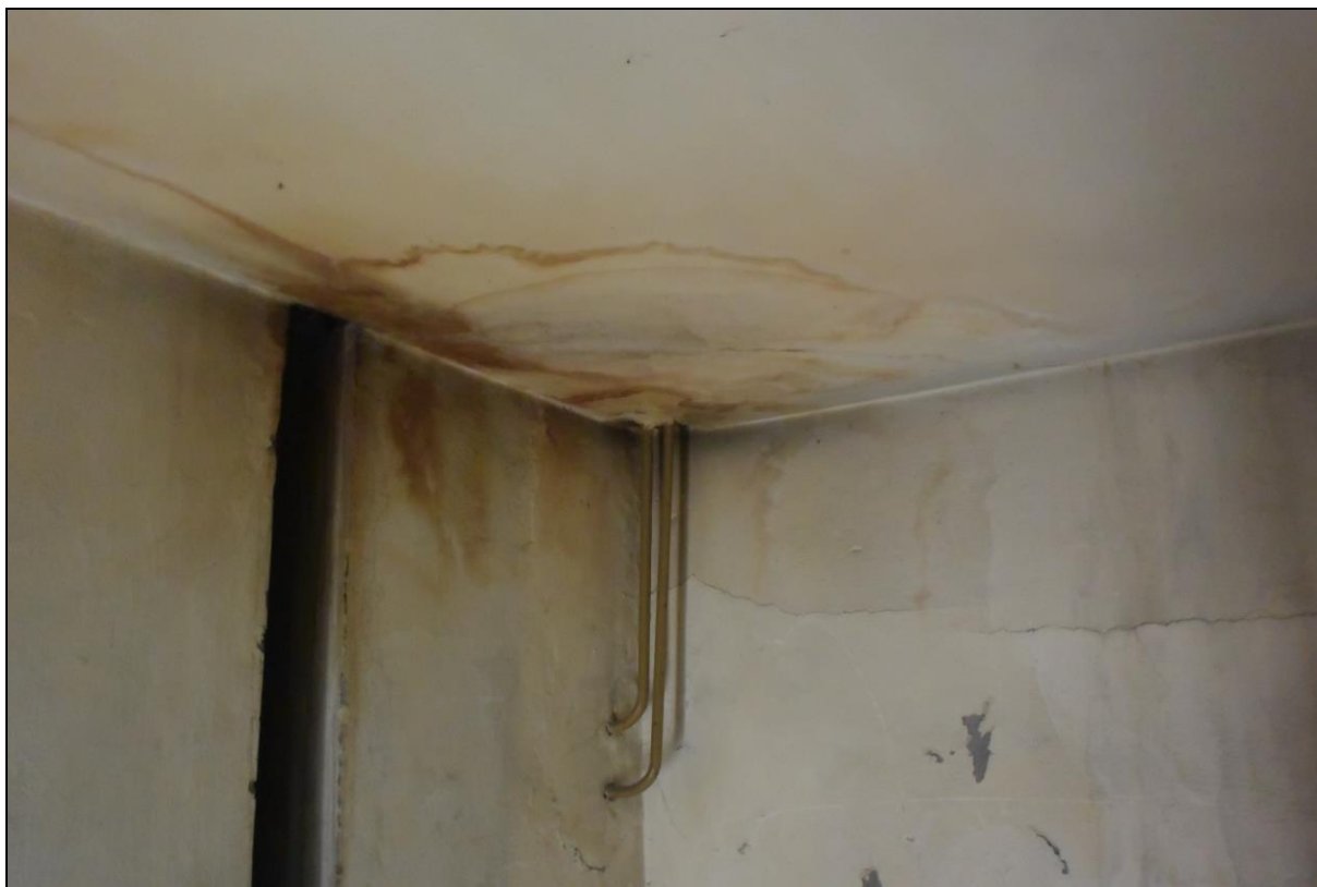
Foto 8: Detail zatékání do stropní desky, lokální degradace a koroze materiálu
