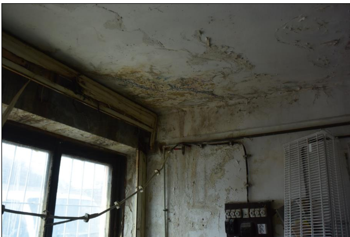
Foto 11: Trhliny ve stropní konstrukci nad 2.NP. Patrné stopy po zatékání do konstrukce. Degradace a koroze materiálu.
