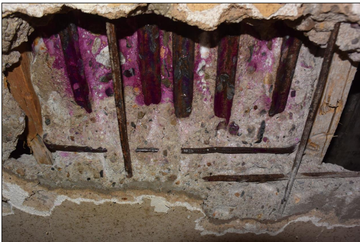
Foto 7: Destrutivní sonda do ŽB trámu, viditelných 5 prutů hlavní výztuže, třmínek, výztužná síť betonové mazaniny, hloubka zkarbonatované vrstvy cca 10-15 mm (trám)
