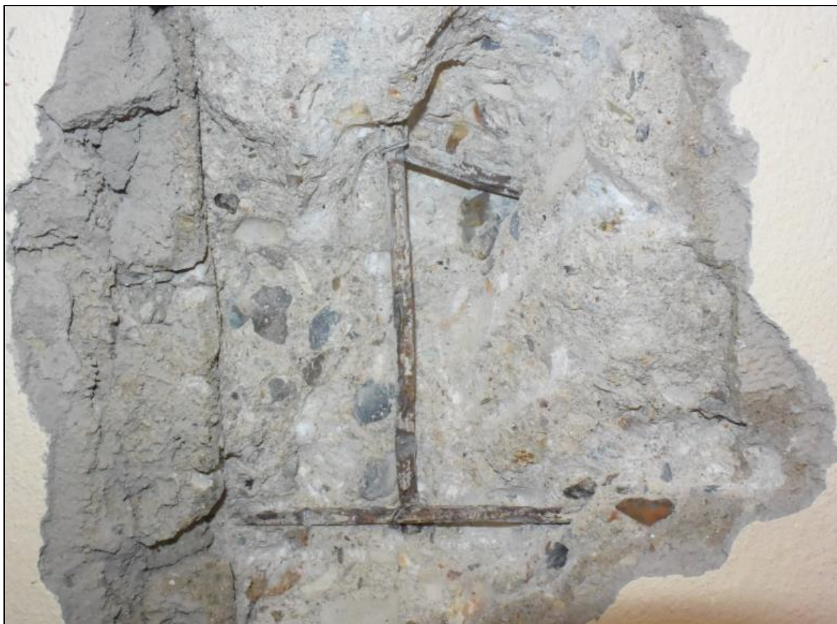
Foto 5: Destruktivní sonda do ŽB stropní desky, viditelné 2 pruty hlavní výztuže
