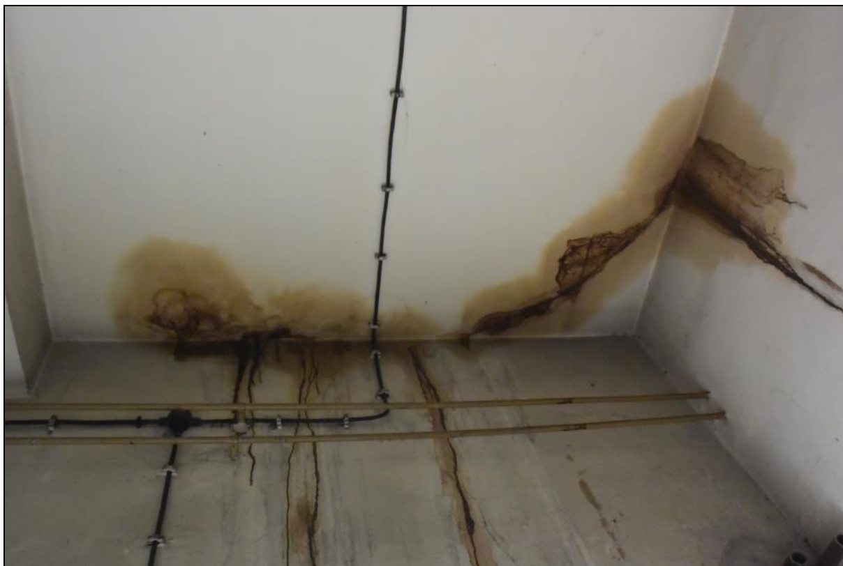
Foto 9: Detail trhlin ve stropní desce nad 1.NP, stopy po zatékání do konstrukce, lokální degradace a koroze materiálu
