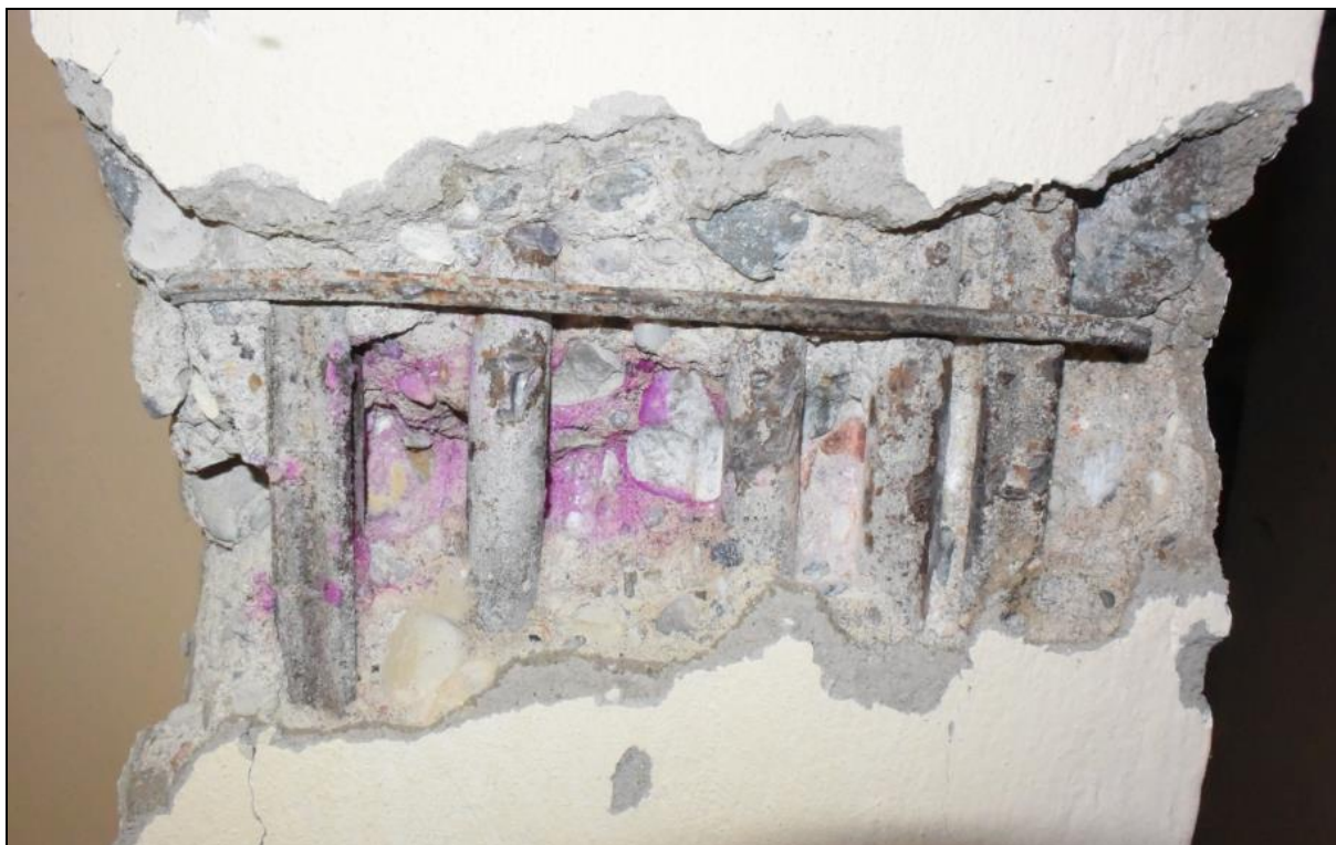
Foto 6: Destruktivní sonda do ŽB trámu, viditelných 5 prutů hlavní výztuže, třmínek, patrná hloubka zkarbonatované vrstvy betonu cca 25-30 mm
