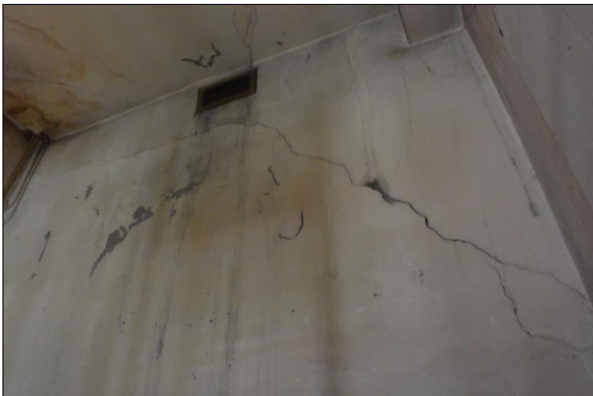
Foto 10: Šikmá trhlina ve stěně v 1.NP. Detail zatékání v rohu
