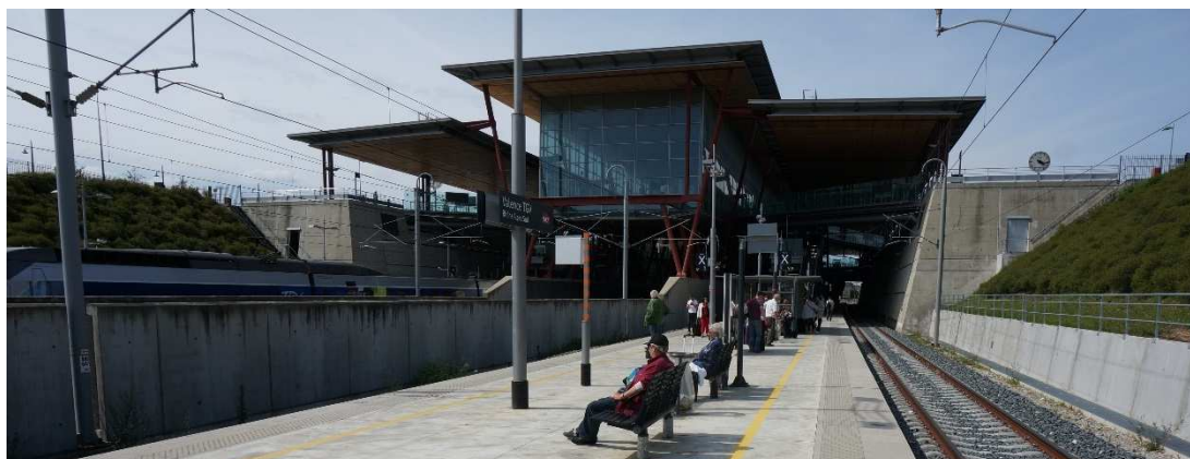
Obrázek 6: Stanice Valence TGV. Dvě předjízdňé koleje s nástupištěm jsou odděleny od průjezdných kolejí nízkou betonovou stěnou.
