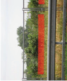
Obr. 12 - Zábrany a oplocení je možné/zádoucí doplnit stavební sítí vhodné barvy (totožné s barvou dočasného orientačního systému) pro lepší orientaci cestujících na staveništi k příchodu/odchodu na/do nástupiště/budovy železniční stanice/zastávky, NAD
