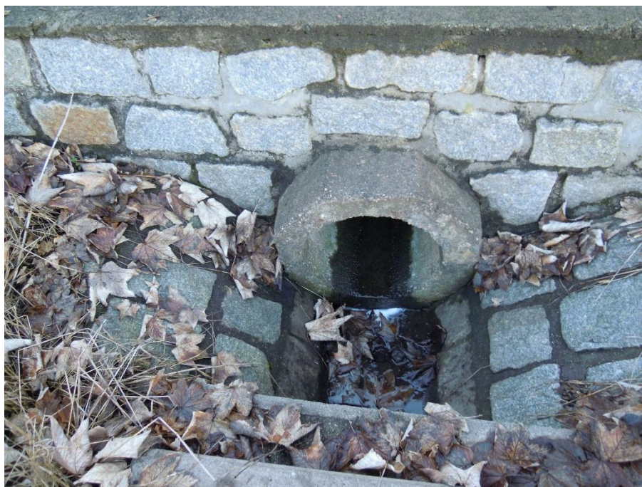
Obr. 1 Výtok stávajícího propustku
