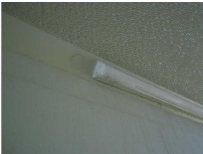
Obrázek 6 - Srážení vlhkosti na stropě uzavřené části druhého podchodu
