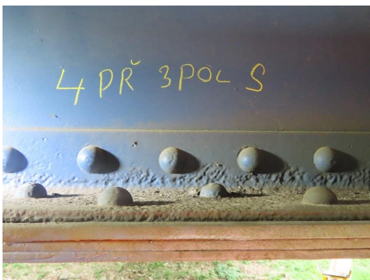
Foto č. 2 Konstrukce K 01 - 4.příčník 3. pole - oslabení
