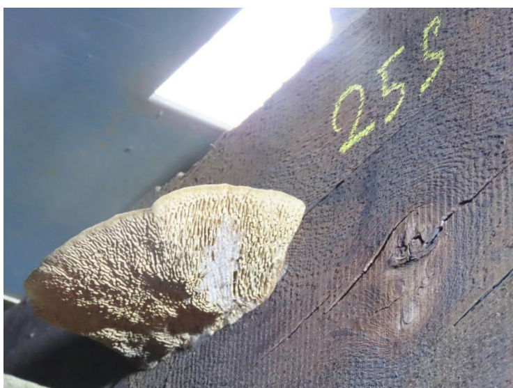
Foto č. 3 Konstrukce K 01 - mostnice č. 25 - dřevokazná houba
