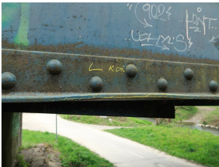
Foto č. 1 Konstrukce K 01 - levý hlavní nosník, konec - deformace
