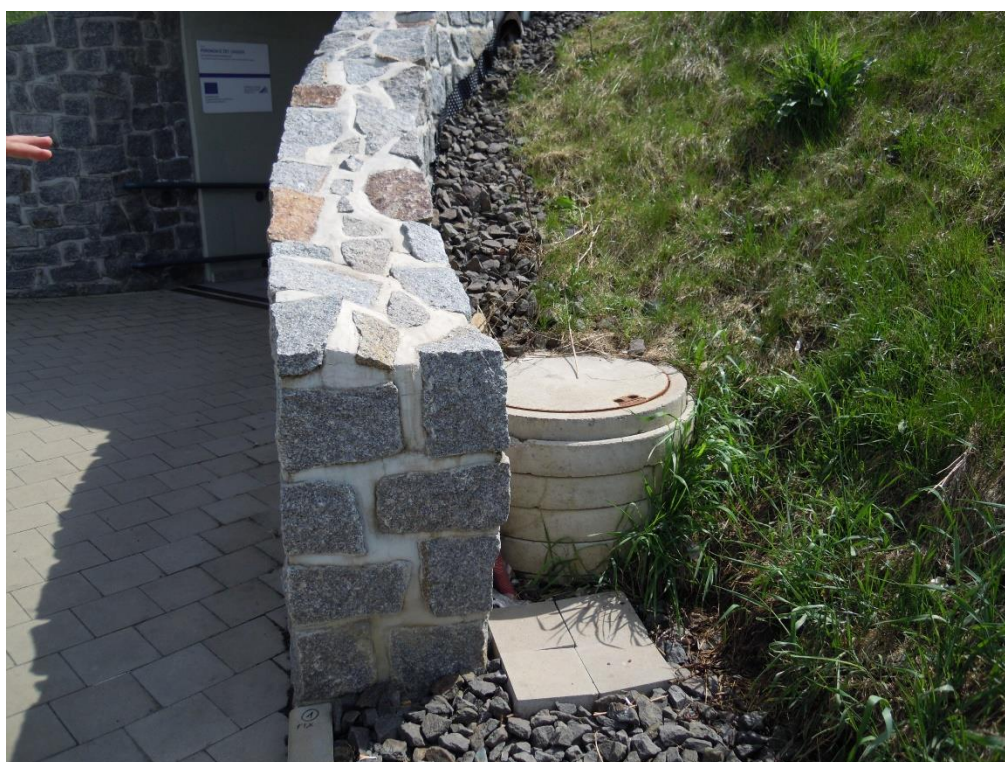
Obr. 4 - Kamenné křídlo s revizní šachtou
