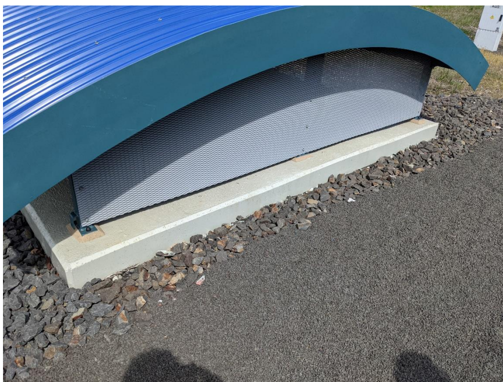
Obr. 6 - Zakončení zastřešení tahokovem
