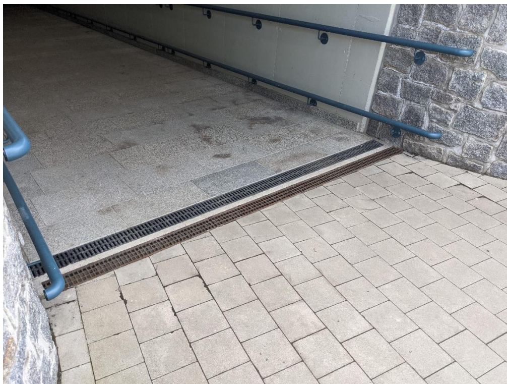
Obr. 5 - Odvodňovací žlábký před vstupem
