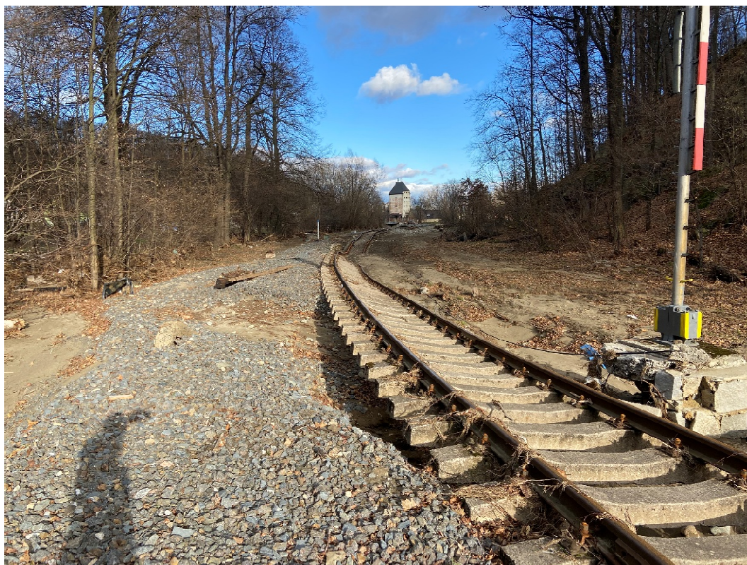
Obrázek 4 – poškozený násep cca 450m po toku od řešeného propustku
