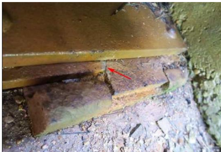
Obrázek 1: poškozená nadložisková deska
