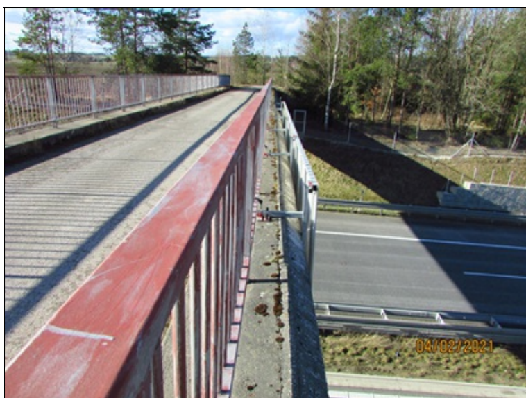
Ocelové závěsy reklamních poutačů jsou přikotveny k žlb. římse.
