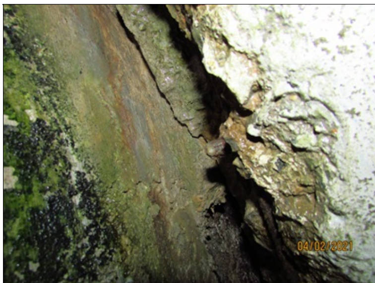
Monolitické dobetonování čel nosníků nad OP1 : odprýsknutý beton, obnažená výztuž koroduje. Prosakování vody.
