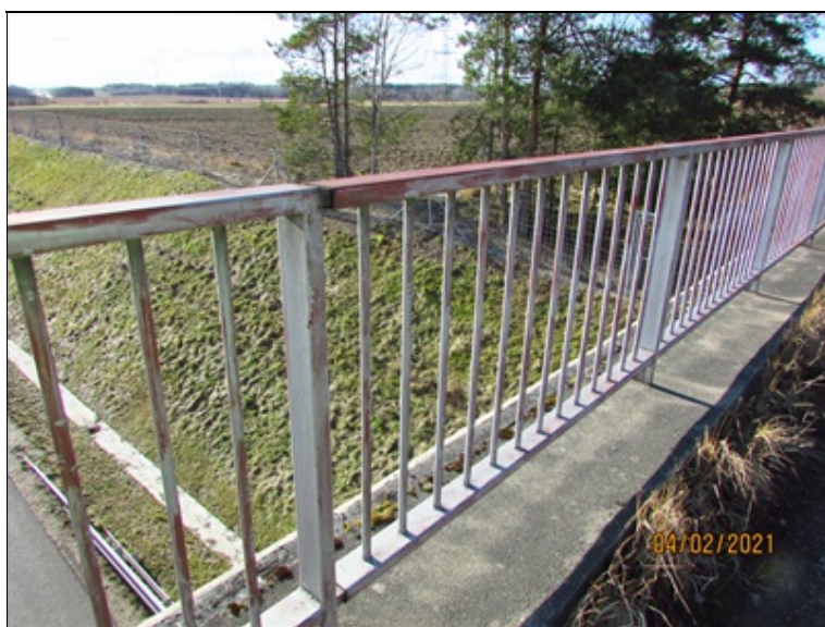
Ocelové zábradlí : lokálně porušená protikoroziční ochrana
