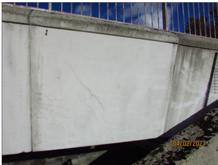
Železobetonový římsový prefabrikát před Op4 vpravo : šikmá trhlina šířky 0,30 mm.
