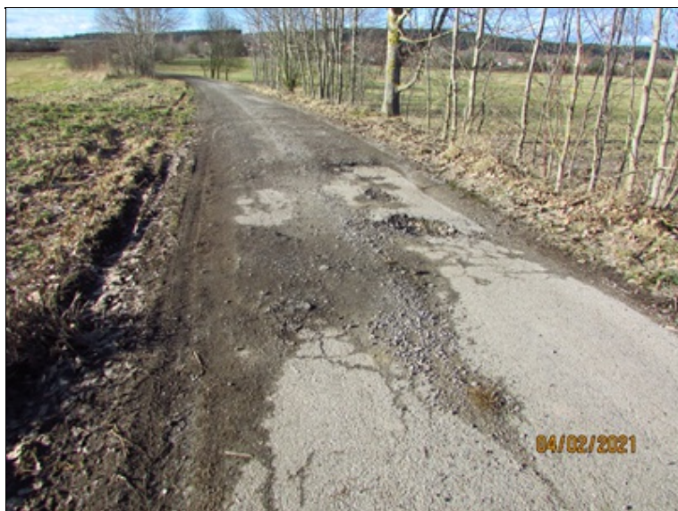
Místní komunikace před mostem : porušená živičná vozovka, výtluky.
