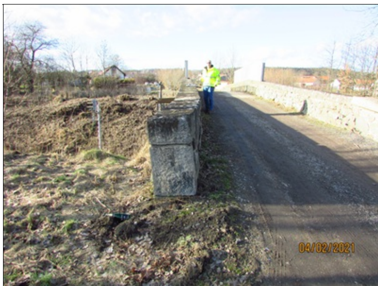
Pravé křídlo OP2 je nakloněné zřejmě od nárazu vozidla
