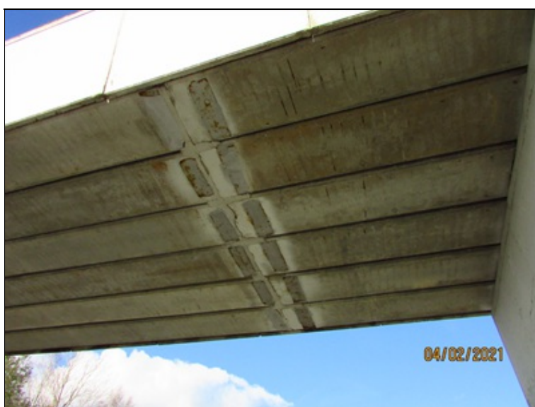
Spodní líc nosné konstrukce, 2. pole. Provizorní kloub před P3 : zabetonované ocelové plechy korodují. Nosníky VS-T : nad korodující měkkou výztuží odstřeluje krycí vrstva betonu.
