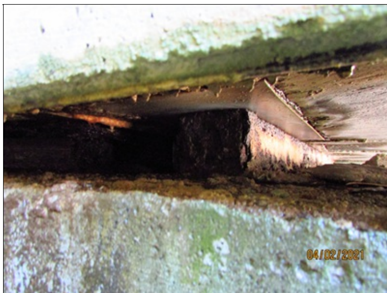
OP1 : ocelové kolejnicové ložisko hloubkově koroduje
