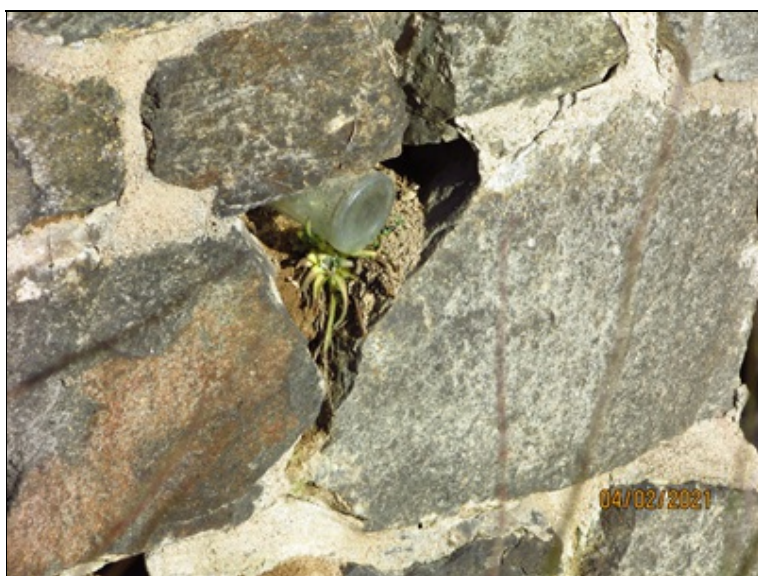
Čelní zeď. Porušené spárování, vegetace
