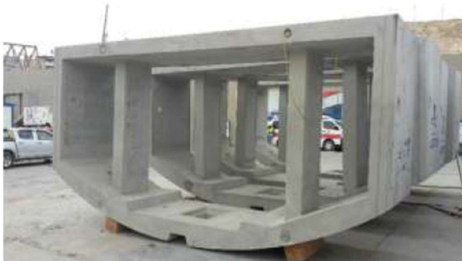
Obr. 38 Prefabrikace dna tunelu, zdroj f. Herrenknecht
