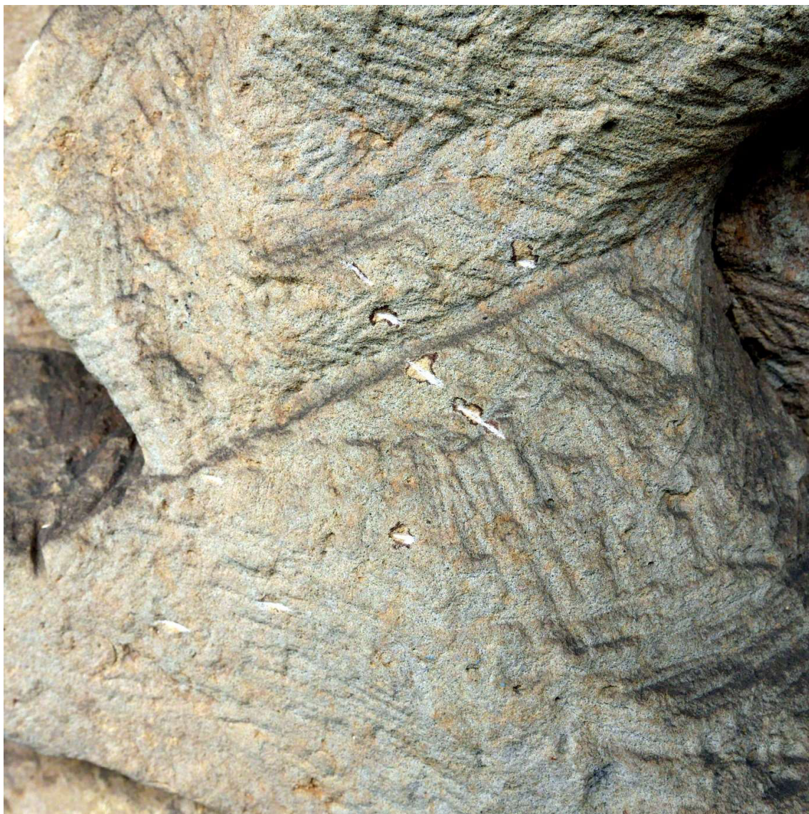
Mechanické poškození povrchu
