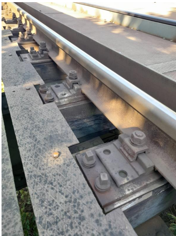
Obr.č.3: Stávající atypické upevnění (MA91 (včetně) - MA110 (včetně) - ocel. plech pod podkladnicí).
