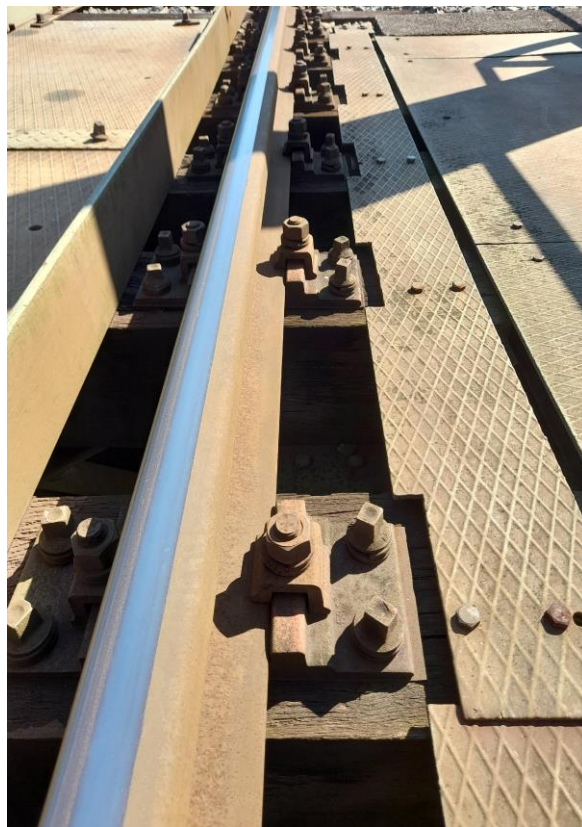
Obr.č.2: Stávající komplety ŽS4 s žebrovou podkladnicí S4.
