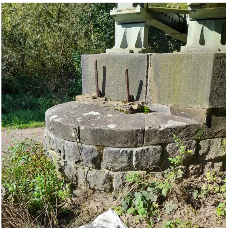
Obr.č.1: Stávající pilíř P01 - ocelové trny.
