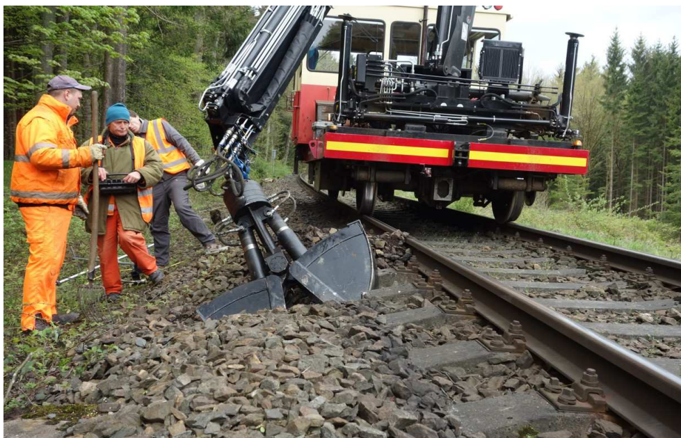
Foto 3: Strojní hloubení sondy K4 v km 175.010
