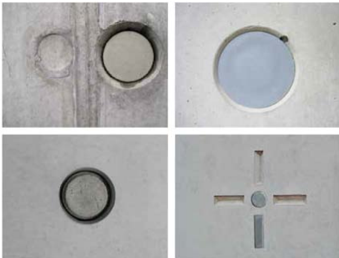
(23) Obr. F.2 – Různé způsoby uzavření spínacích otvorů
