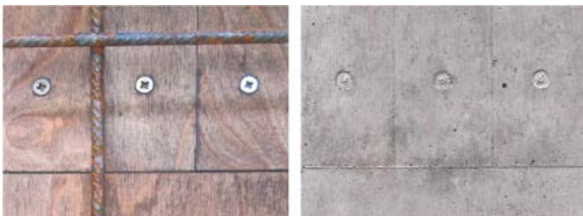
b) z pohledové strany u nosíkového nebo atypického bednění (vlevo bednění / vpravo povrch betonu)
