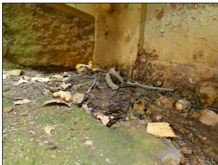
Obr. č. 3 – Konstrukce K 01 – ložisko na O 02 vlevo – porušené zalití
