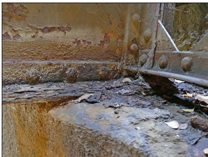
Obr. č. 2 – Konstrukce K 01 – vlevo na konci – korozní oslabení dolního krčného úhelníku
