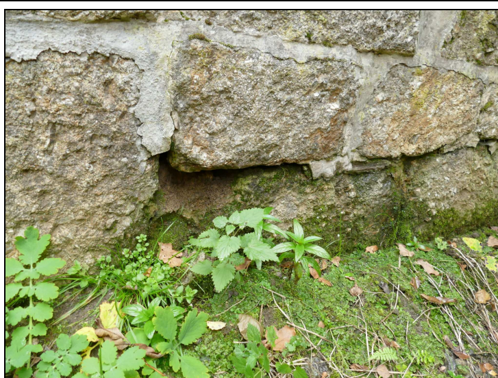
Obr. č. 6 – Opěra O 02 – rozšířená část vlevo – vyplavené spárování, zvětralý kamen
