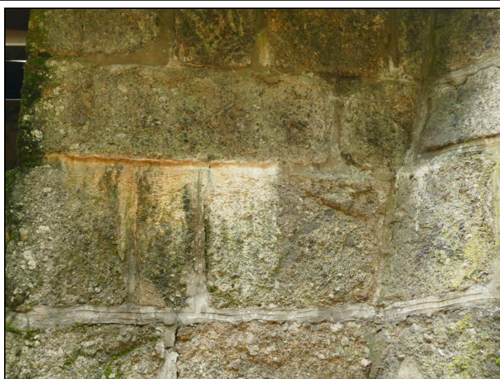
Obr. č. 5 – Opěra O 02 – závěrná zeď – vpravo z boční strany průsaky vody s výluhy pojiva
