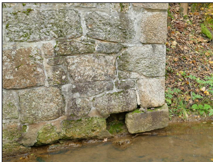
Obr. č. 4 – Opěra O 01 – rozšířená část vlevo – vyplavené spárování, vypadnutý a vysunutý kamen
