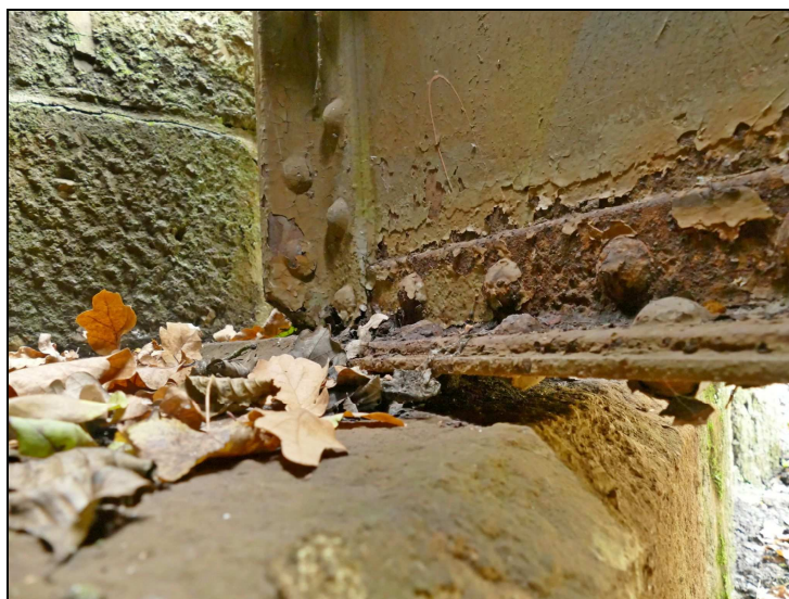
Obr. č. 1 – Konstrukce K 01 – vlevo na začátku – korozní oslabení dolního krčného úhelníku
