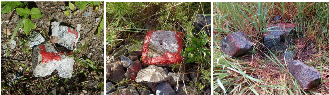
Obrázek 8 Ukázka zničených bodů sekáním trávy
