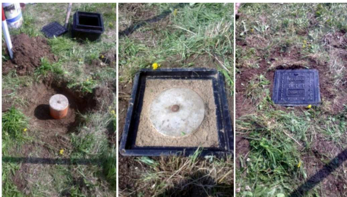
Obrázek 41 Příklad řešení plastové šachty hranaté
