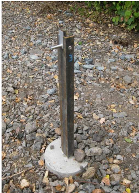
Obrázek 20 Otevřený profil konstrukce sloupku ŽPSV
