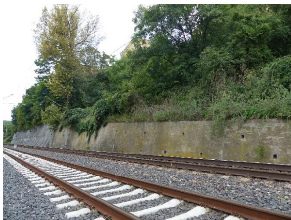
Obrázek 13 Opěrná zeď podél železniční tratě na západním okraji Litoměřic – v rámci optimalizace navrženy úpravy nad římskou, které se mohou dotknout některých dřevin (zpravidla podlimitních)
