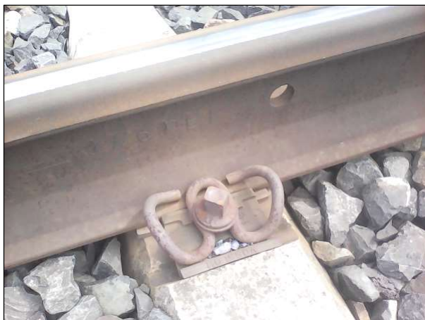
Detail železničního svršku, nová kolej (60 E1)
