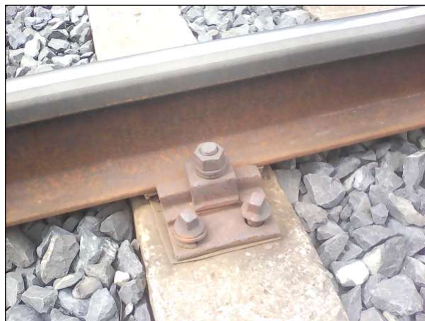
Detail železničního svršku, stará kolej (R 65)
