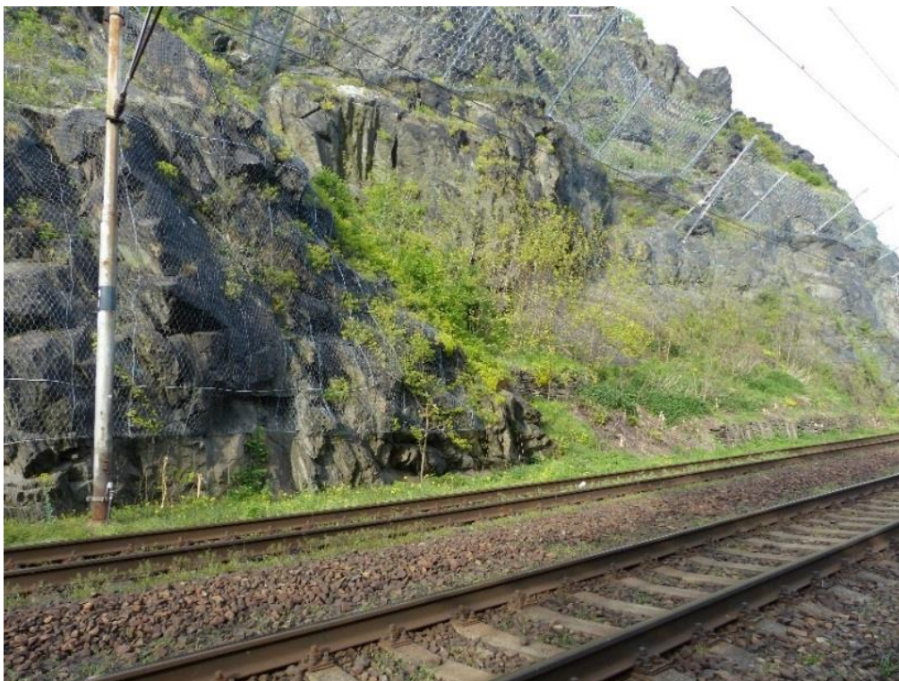
Obrázek 24 Způsob sanace skal a svahů v km 415,700 - 415,970 tratě, tj. v úseku PR Kalvárie (foto: P. Švehlík)
