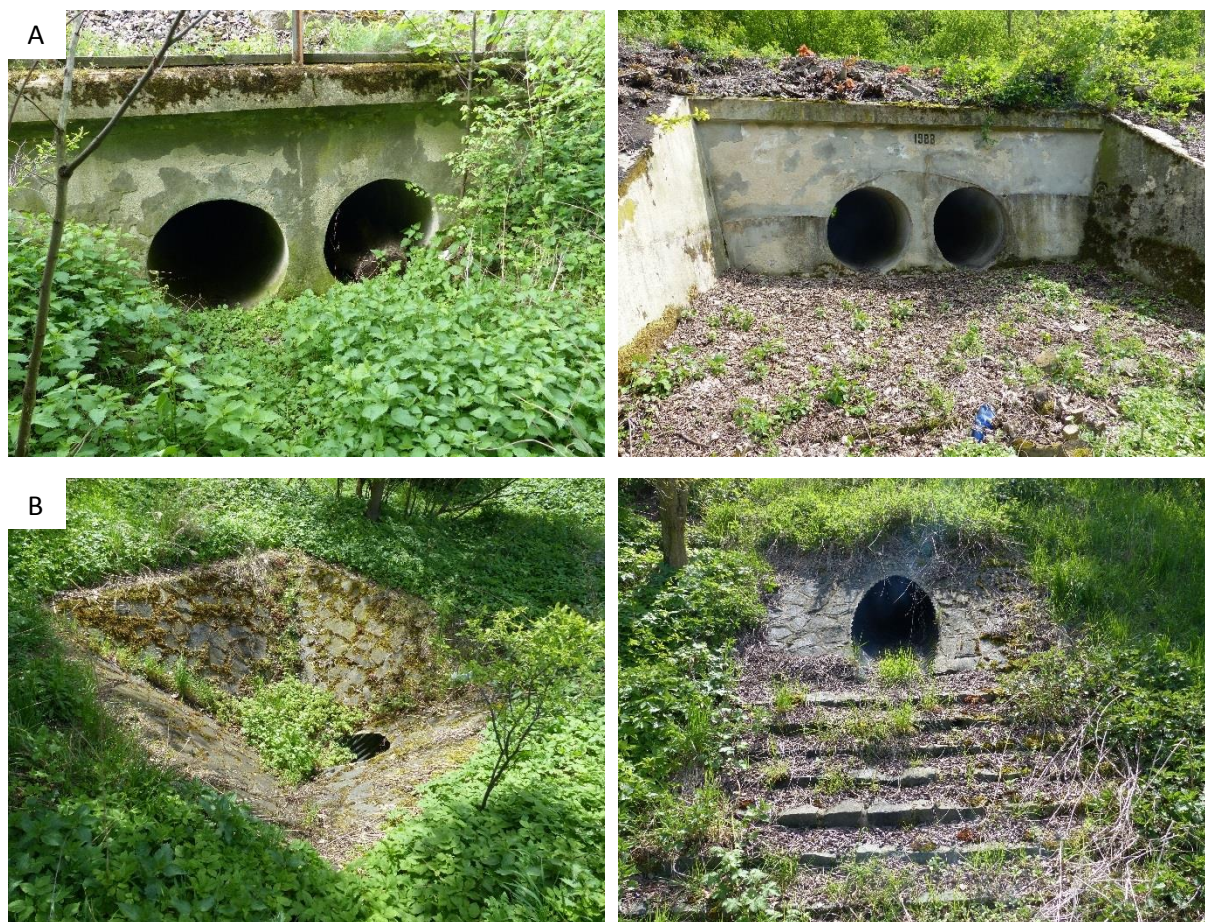
Obrázek 23 Prostupy pod železniční trati – A. cca km 425,312: plynulý přechod do okolí napravo od trati (ve směru Litoměřice – Střekov; levá fotografie) i nalevo od trati (pravá fotografie); B. cca km 423,890: sklon stěny u ústí prostupu napravo od trati umožňující bezproblémový únik živočichů (levá fotografie), stejné platí i nalevo od trati nehledě na jistou stupňovitost (pravá fotografie) (foto: P. Švehlík 2017)
