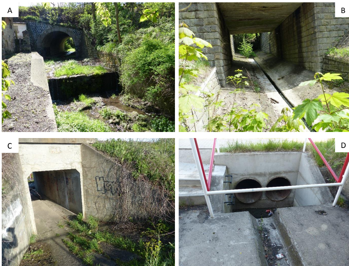
Obrázek 17 Úseky křížení vodních toků s železniční tratí – A. km 423,467: Tlučenský potok: výškový stupeň za křížením s železnicí, koryto s nánosy jemnozrnného materiálu; B. km 424,238: Němečský potok: přírodě značně vzdálený charakter podmostí - betonové koryto; C. a D. km 418,982: bezejmenná vysychavá vodoteč: přírodě značně vzdálený charakter podmostí - betonové koryto zakončené migračně obecně problematickou šachtou vzhledem ke křížení s cyklostezkou (foto: P. Švehlík 2017)
