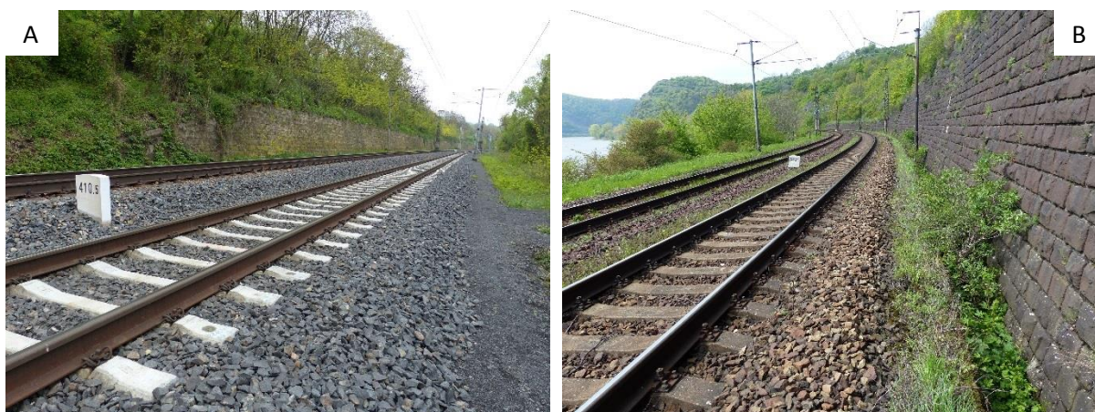
Obrázek 11 Vedení železniční tratě v úsecích stabilizace přilehlých svahů kamennými/opěrnými zdmi – A. cca km 410,4: intravilán Litoměřic; B. cca km 415,0: území mezi Velkými Žernoseky a PR Kalvárie (foto: P. Švehlík 2017)
