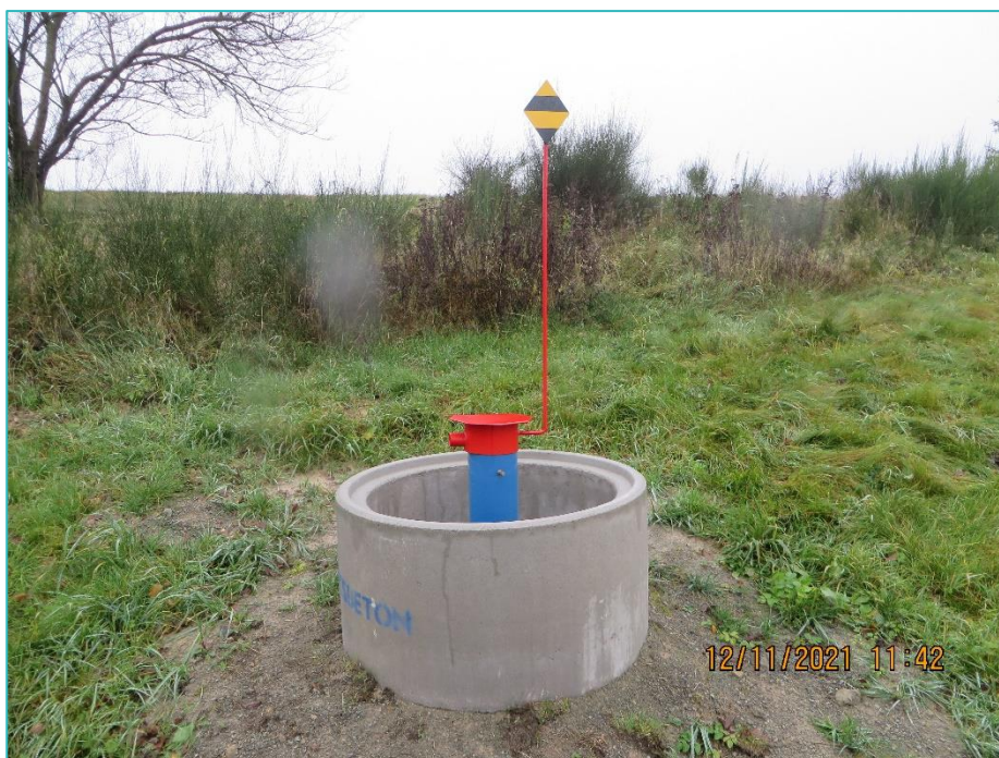
Obrázek 9 Požadovaná ochrana zhlaví vstrojeného vrtu
