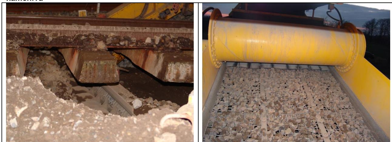
Obr. č. 6 Odtěžování štěrkového lože přímo pod kolejovým roštem a pohled do třídiče kameniva
