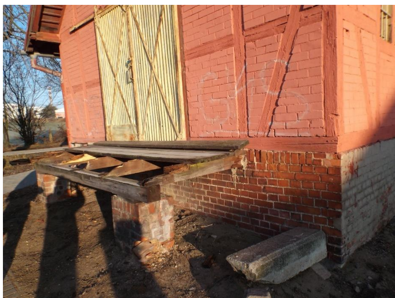
Obr. č. 5 – Pohled přístavek z hrázděného zdiva, havarijní stav rampy
