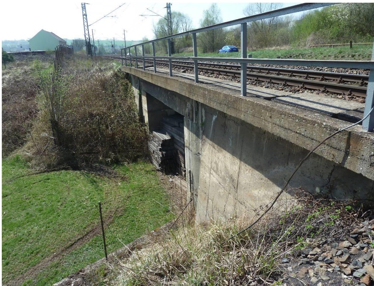
Obr. km 43,489 – most, pravá stěna mostu zazděná
