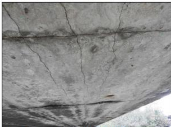
obr. 14: K 03 pohled vpravo podélné trhliny
