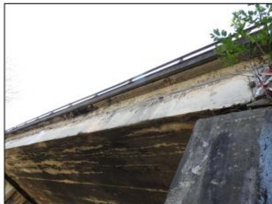
obr. 15: K 03 zprava, prostupující výztuž a výluhy pojiva
