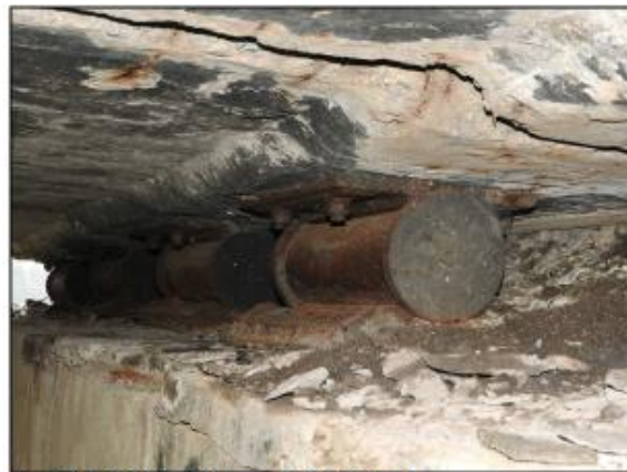
obr. 13: K 02 ložiska na pilíři P 02 vlevo
