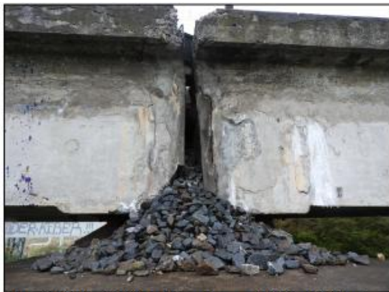
obr. 12: K 02 - K 03 styčná spára nad pilířem P 02 vlevo
