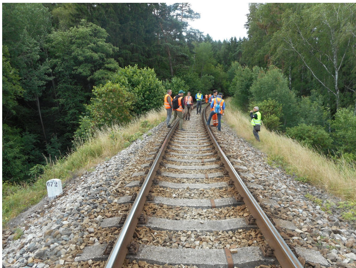
Obr. 3: Šířkově nevyhovující těleso náspu v km 67,200
