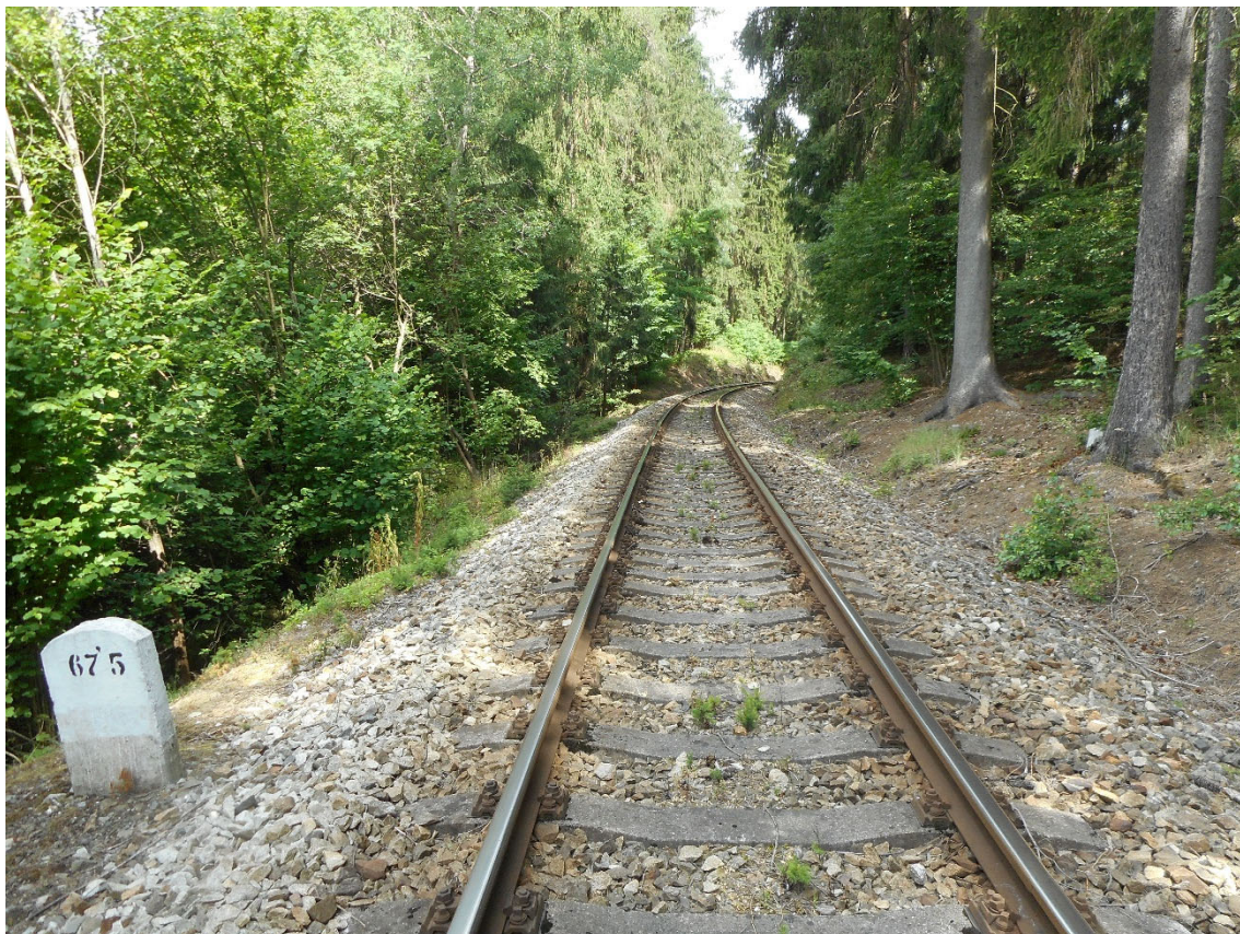
Obr. 5: Šířkově nevyhovující těleso náspu v km 67,500 – pohled proti směru staničení
