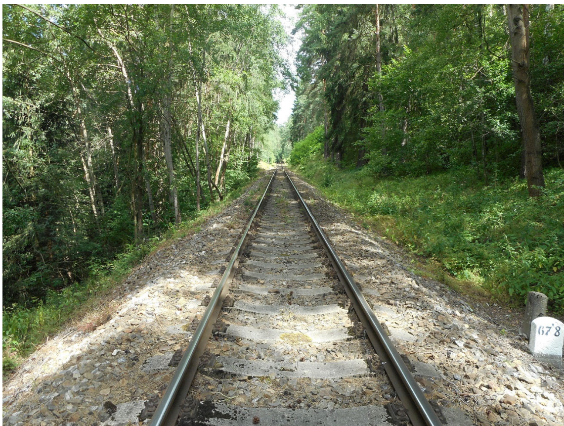
Obr. 6: Šířkově nevyhovující těleso náspu v km 67,800 – pohled proti směru staničení
