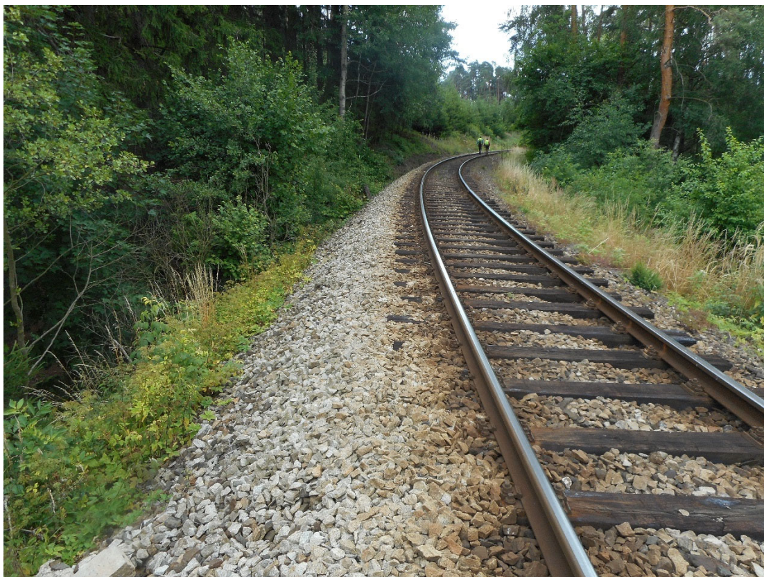
Obr. 1: Šířkově nevyhovující těleso náspu v km 66,050
