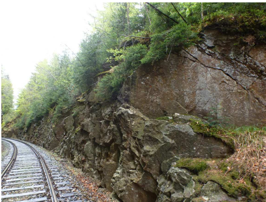
Část skal. svahu, která bude zajištěna ocel. dvouzákrut. sítí 80 x 100 mm.
