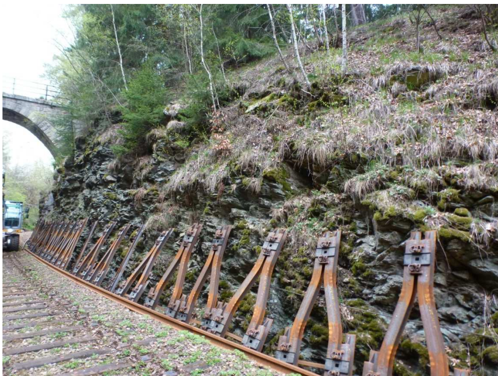
SO 02-06-02: ZÚ a část, která bude zajištěna ocel. sítí 80 x 100 mm.
