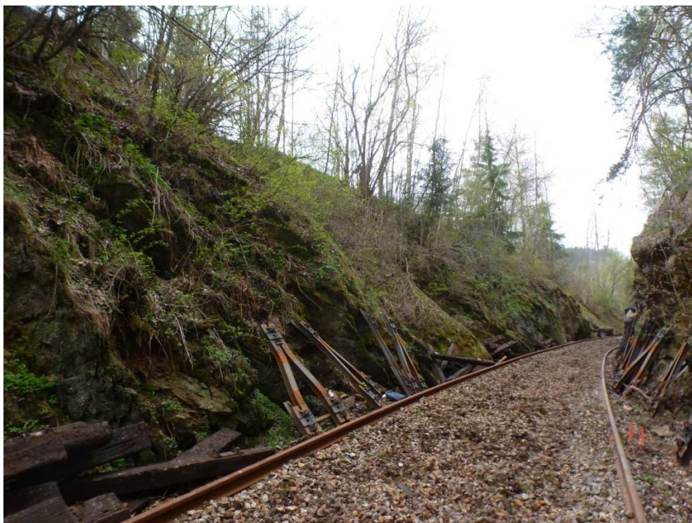
SO 02-06-02: KÚ a část která bude zajištěna ocel. sítí 60 x 80 mm.
