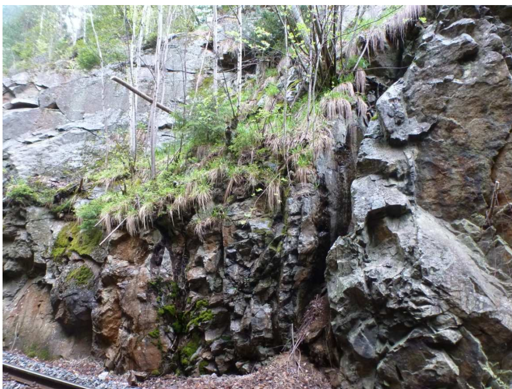
Vertikální puklina bude vyplněna kamennou vyzdívkou na cement. maltu.
