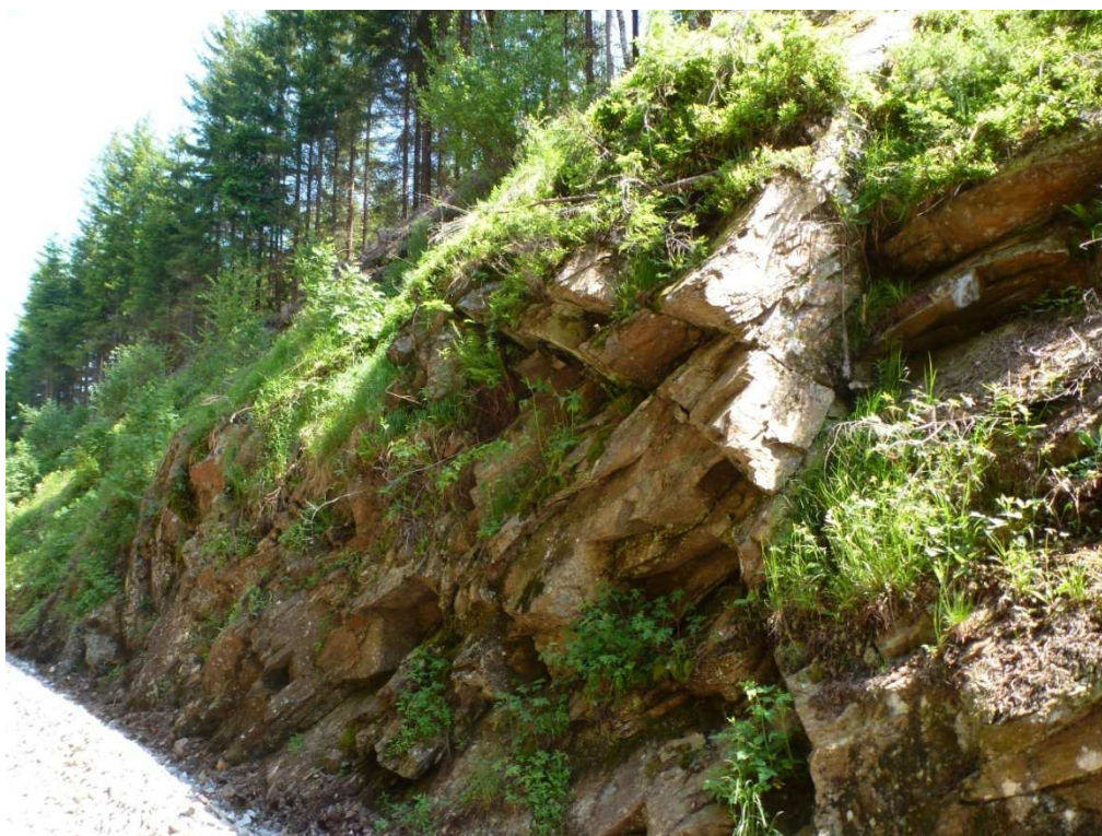
SO 02-06-01: část skal. svahu, která bude zajištěna ocel. sítí 60 x 80 mm.
