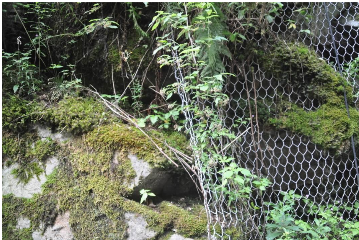
Detail skalního svahu s již instalovanou sítí – porovnání upravené a neupravené části
