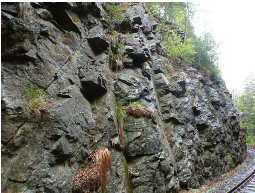
Levá strana zářezu a část, která bude zajištěna pomocí lokálního kotvení.
