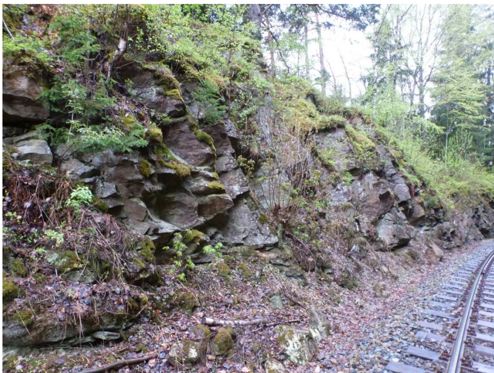
Pravá strana zářezu a část, která bude zajištěna také sítí 80 x 100 mm.
