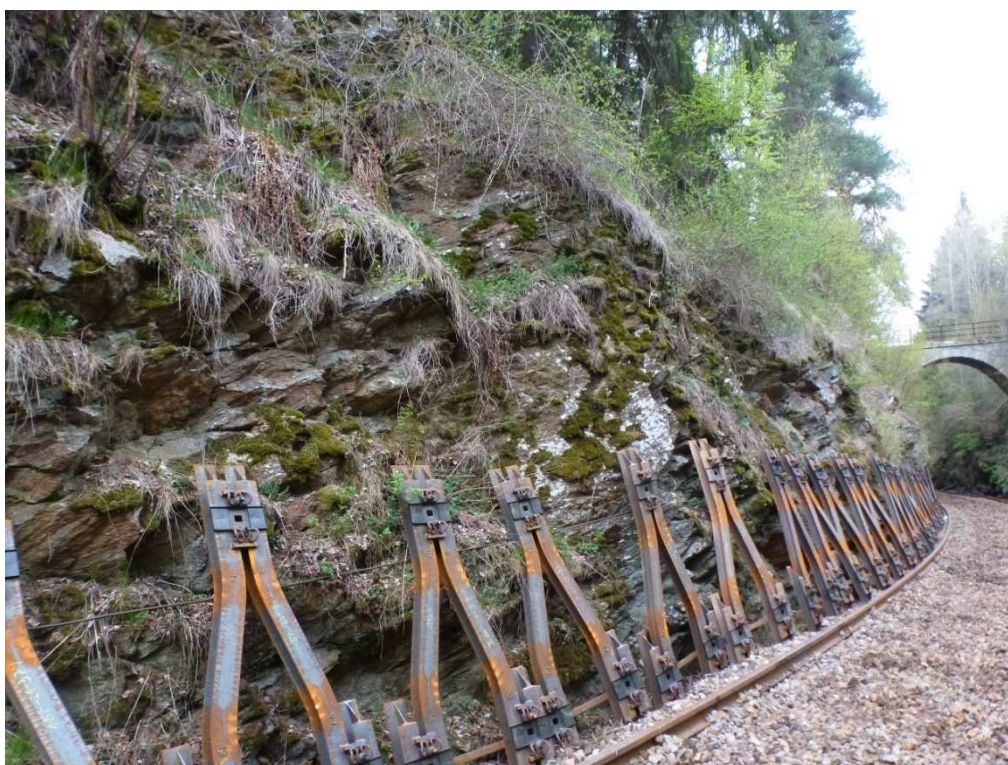
SO 02-06-02: Část skal. svahu, která bude zajištěna ocel. sítí 80 x 100 mm.
