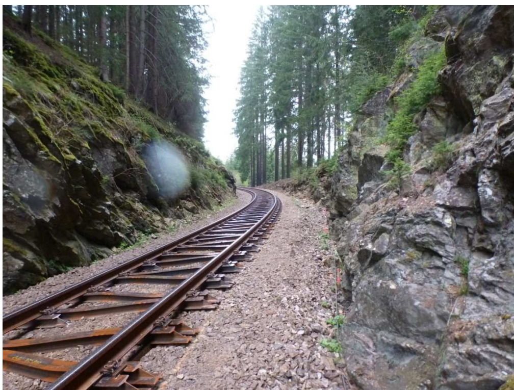
SO 02-06-03: KÚ, vlevo bude ocel. síť 80 x 100 mm, vpravo 60 x 80 mm.
