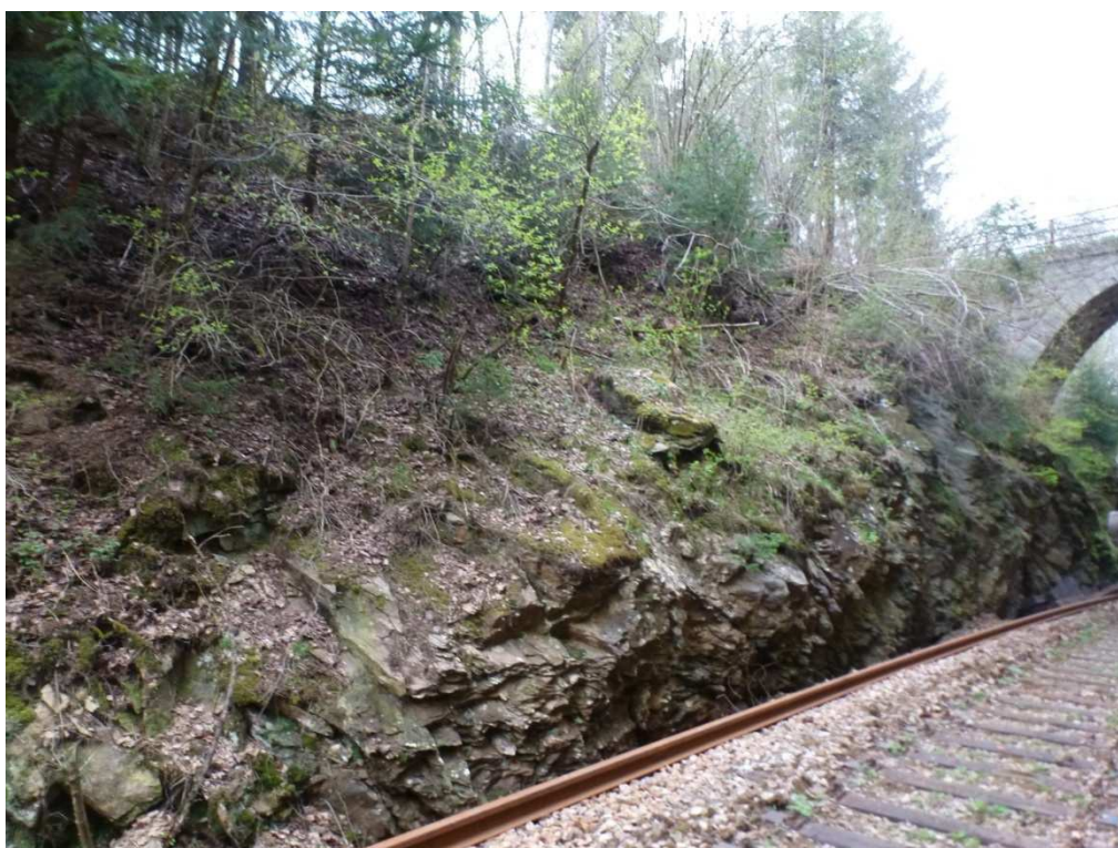
SO 02-06-02: ZÚ, kde bude instalován ochr. plot a ocel. síť 80 x 100 mm.
