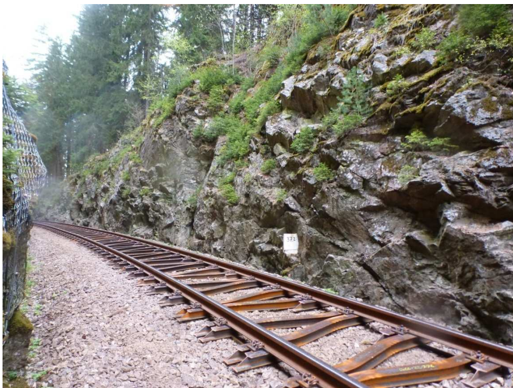
SO 02-06-03: vlevo stáv. sanace, vpravo bude instal. ocel. síť 60 x 80 mm.
