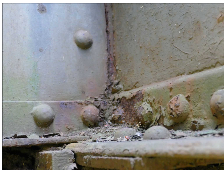
Foto č. 1 – Konstrukce K 01 – hlavní nosník, nad ložisky korozní oslabení
