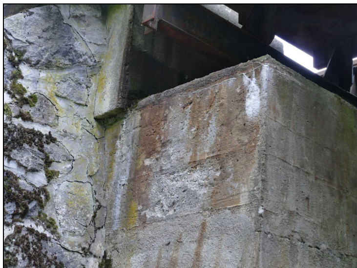
Foto č. 5 – Opěra O 02 – úložný práh z čela vlevo, vodorovná trhliny s výluhy pojiva
