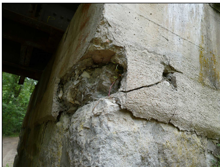
Foto č. 6 – Opěra O 02 – vpravo, odpadá povrchová úprava
