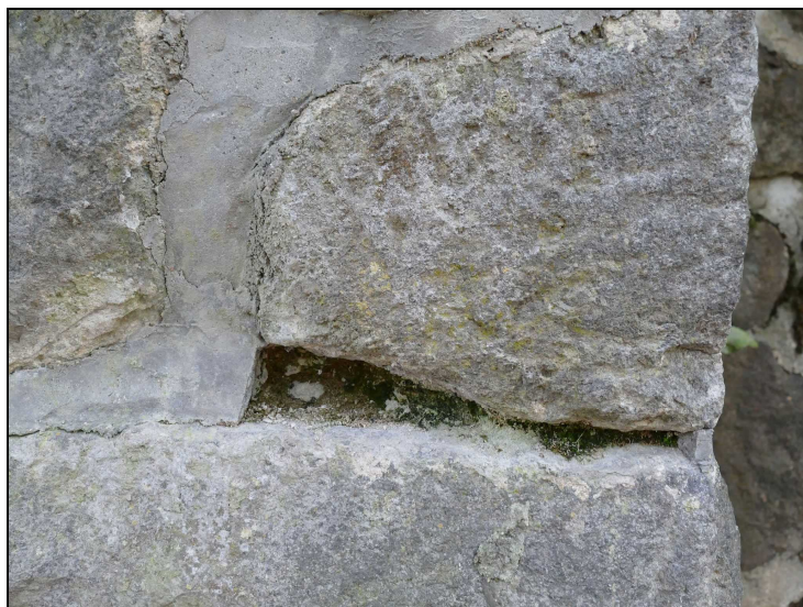
Foto č. 4 – Opěra O 01 – vypadané spárování
