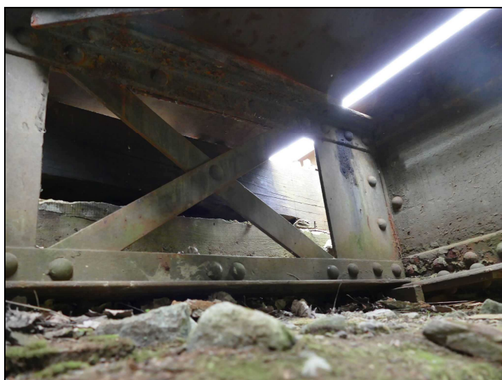
Foto č. 2 – Konstrukce K 01 – příčník porušené PKO
