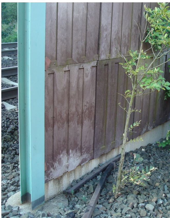
Obr.2 Stávající PHS – Panely z dílů nelze opravit, nemají potřebnou statickou tuhost ani vlastnosti
