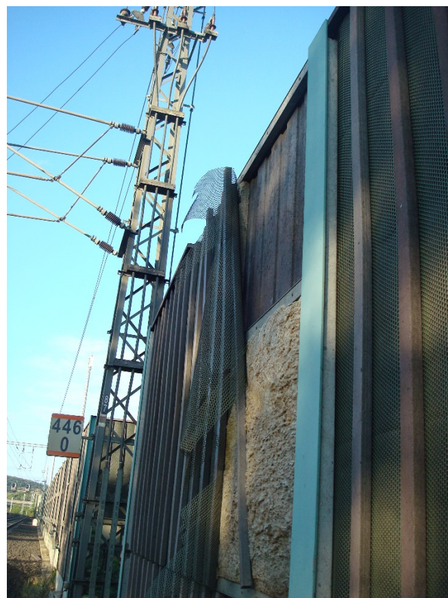
Obr.2 Stávající PHS – Panely z dílů nelze opravit, nemají potřebnou statickou tuhost ani vlastnosti
