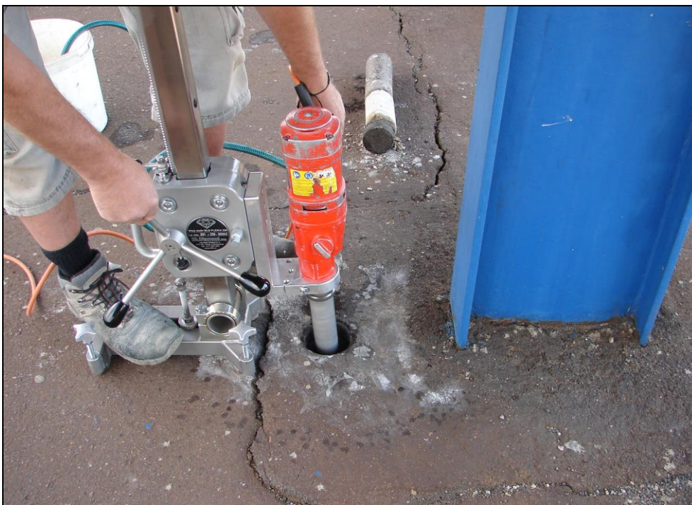
Foto 1: 2. nástupiště, základ sloupu 2, jádrový vývrt 1; odběr jádrového vývrtu, všechny jádrové vývrty byly vedeny mírně šikmo do nitra základu
