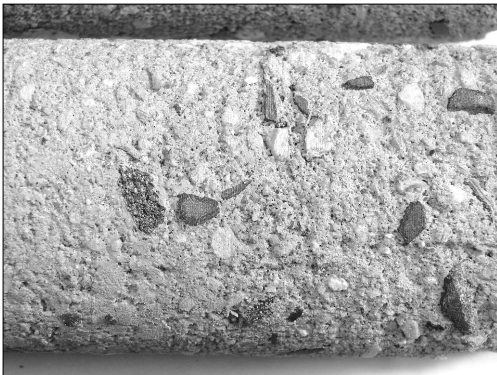
Foto 11: 3. nástupiště, základ sloupu 13; silně pórovitá struktura betonu základu sloupu (pro zvýraznění černobílé foto)
