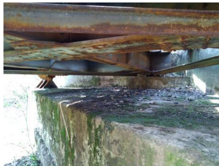
Pohled na most km. 74,831 – pohled z boku a NK uložení na opěře - koroze
