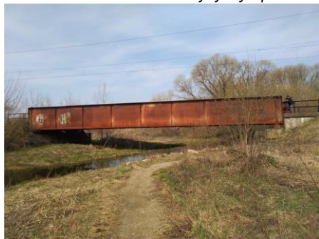
Pohled na most km. 74,831 – pohled z boku a NK uložení na opěře - koroze
