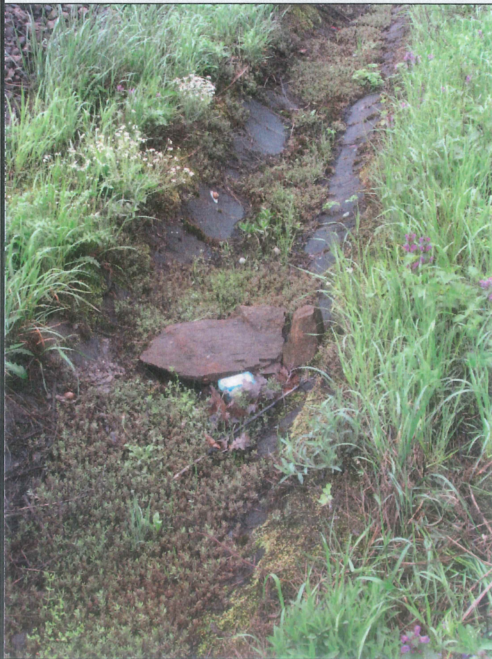
▲ Detail betonového žlabu s osypanými kameny z objektu
