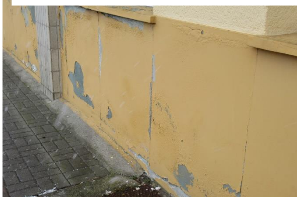
Trhlina mezi bloky ve výplňovém zdivu
