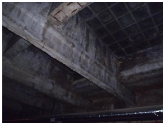
Zatékání do stropní konstrukce v suterénu u prosvětlovacích otvorů
