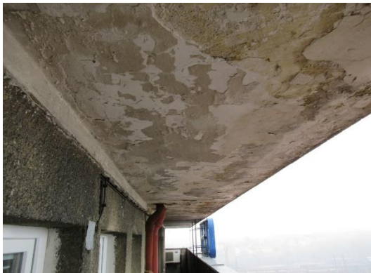
Zatékání a degradace betonu stropní desky nad ochozem, 6. patro
