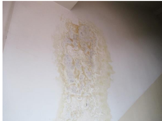
Zatékání do stěny schodišťového traktu, podesta, 2. patro
