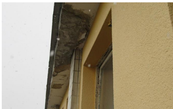
Zatékání do římsy provozní budovy, západ 1
