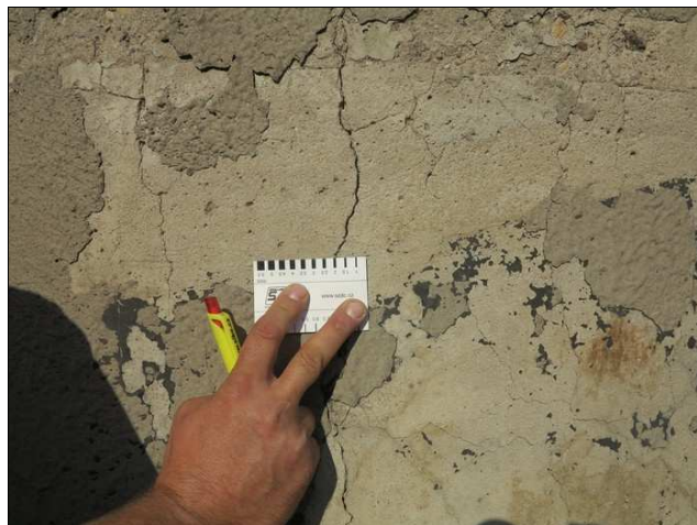
Foto č. 8 - P 02 - trhliny vpravo v dolní části pilíře a odpadlý nástřik
