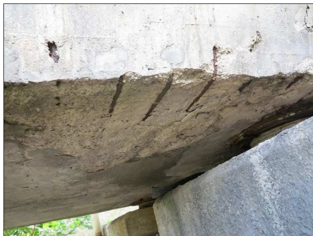
Foto č. 2 - K 01, degradace betonu s obnažením výztuže vlevo nad O 01 z podhledu
