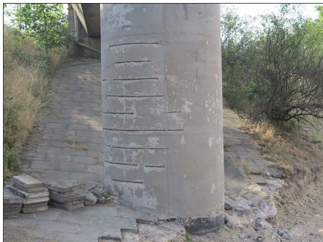
Foto č. 7 - P 01 - obnažení a koroze výztuže s korozí vpravo
