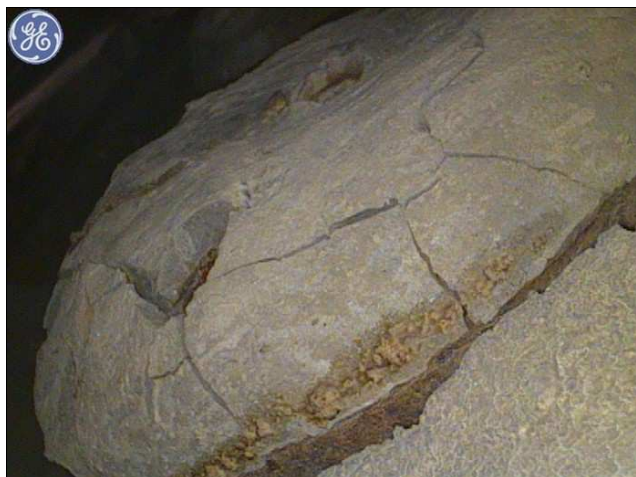
Foto č. 3 - K 01, dolní kotevní oblast vpravo nad O 01 - popraskaný beton
