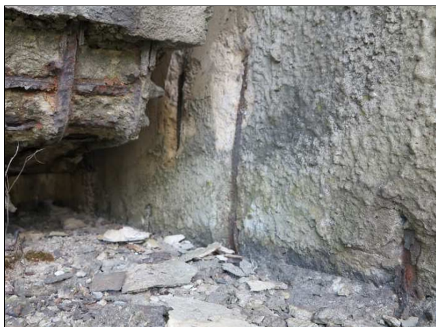
Foto č. 5 - O 01 - závěrná zeď vlevo, degradace betonu s obnažením a korozí armatury
