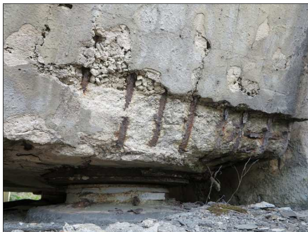
Foto č. 1 - K 01, degradace betonu s obnažením výztuže vlevo nad O 01
