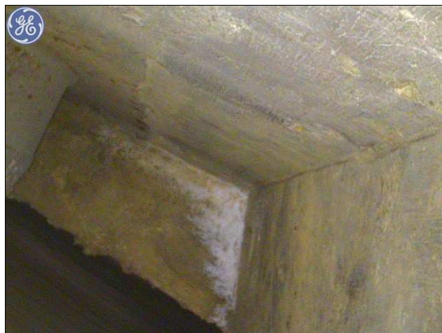
Foto č. 4 - K 01, horní kotevní oblast vpravo nad O 02, průsaky s výluhy
