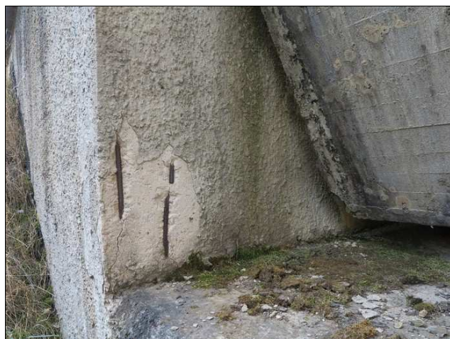
Foto č. 6 - O 01 - závěrná zeď vpravo, degradace betonu s obnažením a korozí armatury
