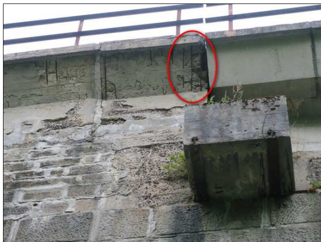
Foto č. 7 - O 02, silná degradace betonu římsy z líce závěrné zdi vlevo.
