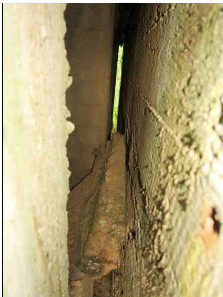
Foto č. 3 - K 01, odpadlý závěr konstrukce nad O 02 vpravo.
