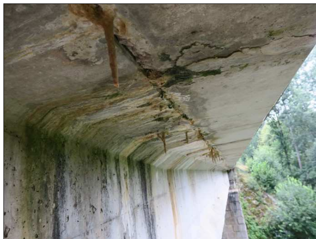
Foto č. 2 - K 01, silné průsaky ve spáře mezi nosníkem a římsovým prefabrikátem.
