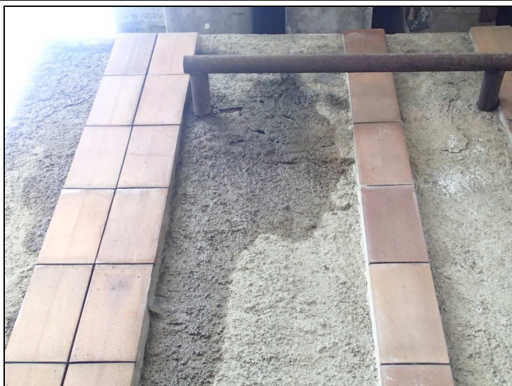
Foto č. 5 – opěra O 02 – průsak vody
