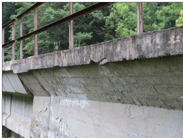
Foto č. 8 - O02, silná degradace betonu římsy křídla vpravo.
