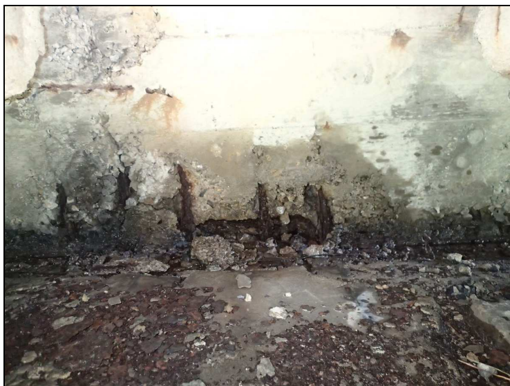
Foto č. 6 – opěra O 02 – závěrná zed' – urezlá armatura
