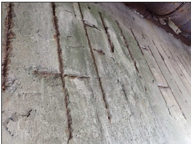
Foto č. 3 – konstrukce K 01 – 4. nosník zleva – obnažené třmínky, nedostatečné krytí
