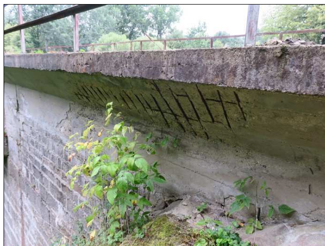
Foto č. 6 - O01, degradace betonu a nedostatečné krytí výztuže na křídle vlevo.
