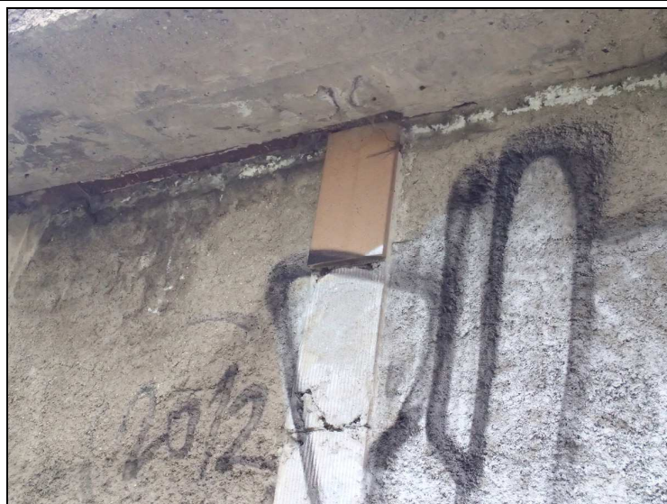
Foto č. 7 – opěra O 02 – křídlo vlevo průsak vody a pojiva
