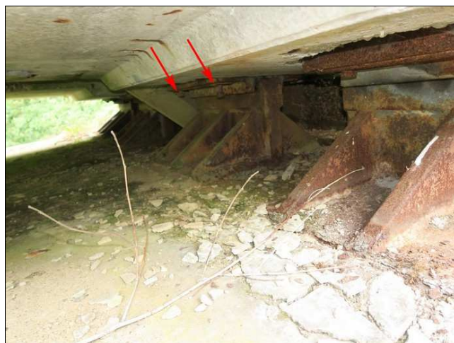
Foto č. 4 - K 01, uvolněné šrouby třetího ložiska na O 02.
