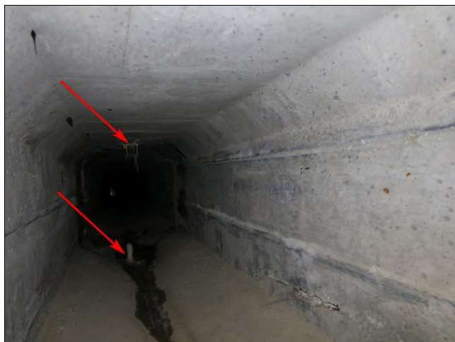
Foto č. 1 - K 01, průsaky ve vnitřní části pravého nosníku.
