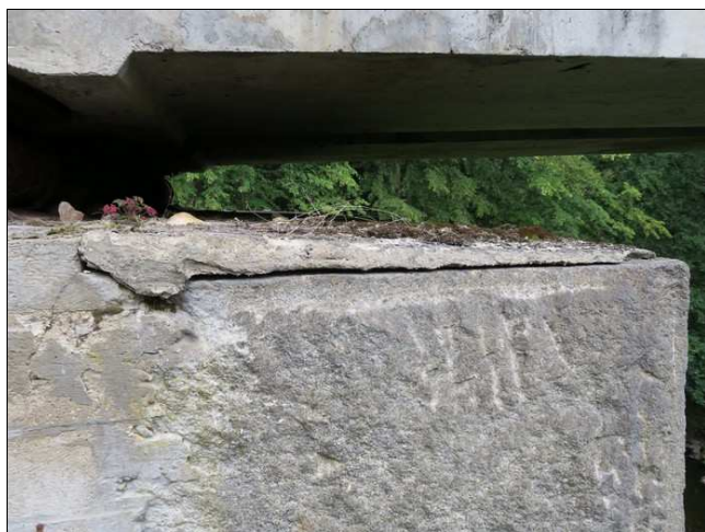
Foto č. 5 - O 01, vzdutá betonová mazanina úložného prahu vpravo.
