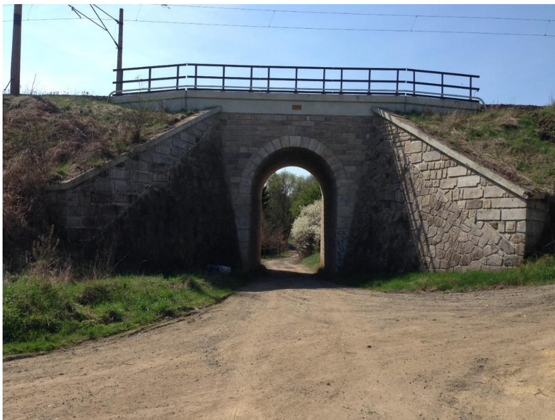
Obr. 6: Nedostačující šířkové uspořádání mostu v ev. km 234,911
