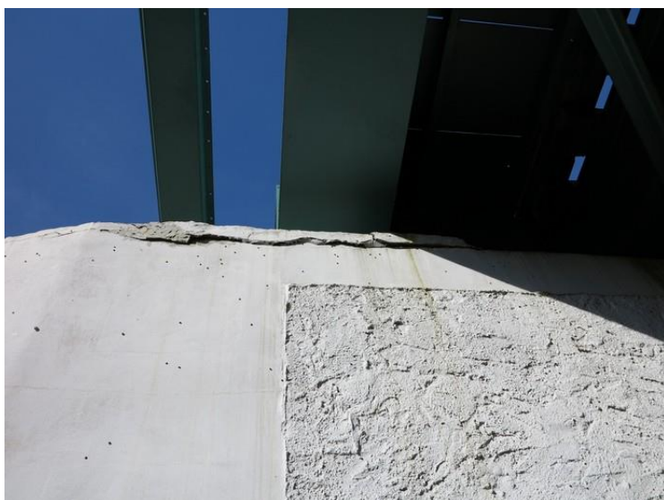
Foto č. 2 P 01 – horní část směrem do otvoru č. 2, vzdutá horní plocha
