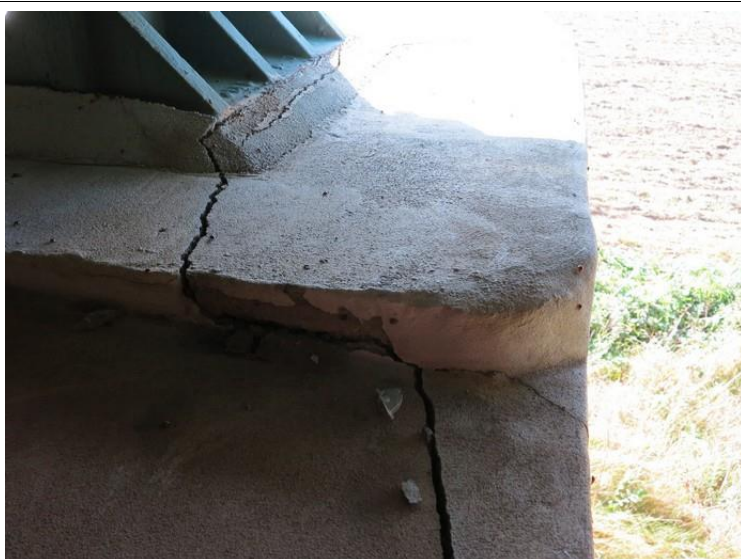
Foto č. 3 P 01 – horní plocha vpravo u uložení K 01, trhlina
