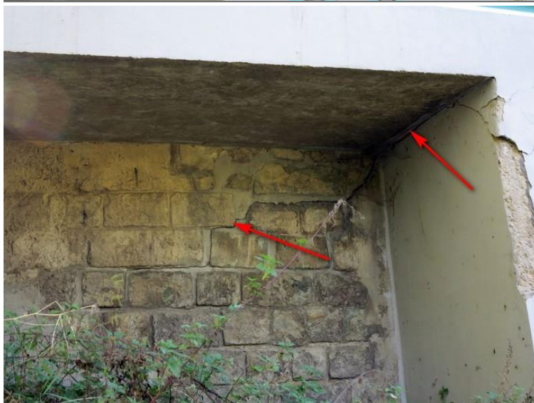
Foto č. 6 O 02 – křídlo vlevo nadzvednutí římsy a trhlina v křídle vlevo
