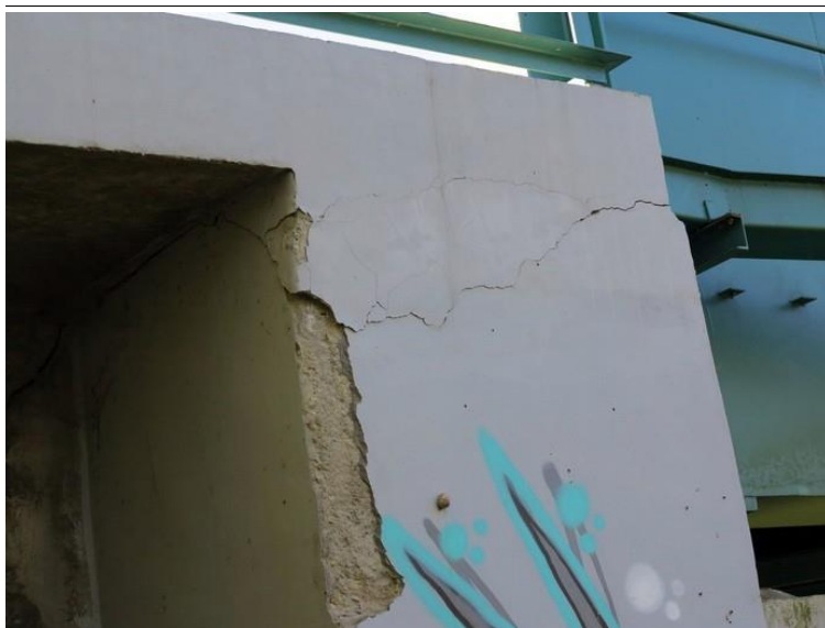
Foto č. 5 O 02 – závěrná zed' vlevo z líce, trhliny a odpadlá úprava
