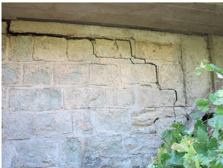
Foto č. 1 O 01 – nadzvednutá římsa a trhlina v křídle vlevo
