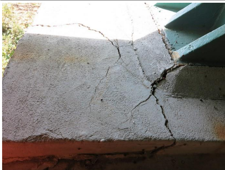
Foto č. 4 P 01 – trhliny v místě uložení K 02
