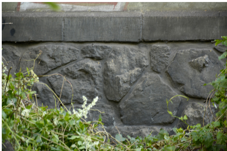
Detail kamenného soklu S fasády.
