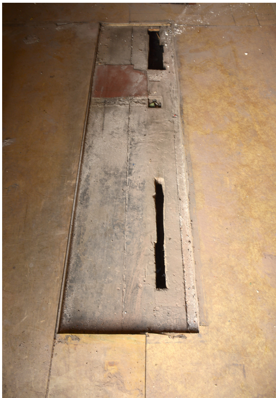
Centrální část podlahy s otvory pro technické vybavení stavědla, pohled k Z.
