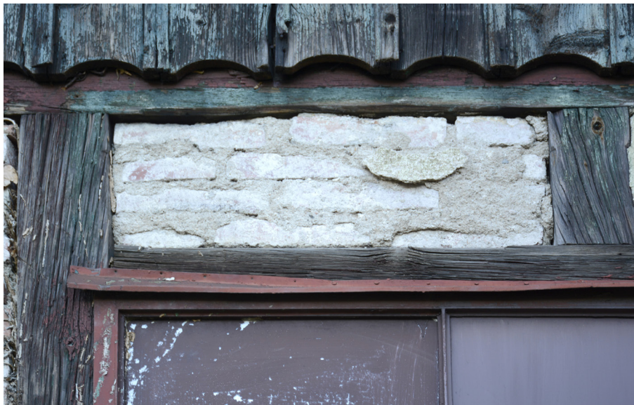
Detail zazdívky výplně nad oknem Z průčelí.
