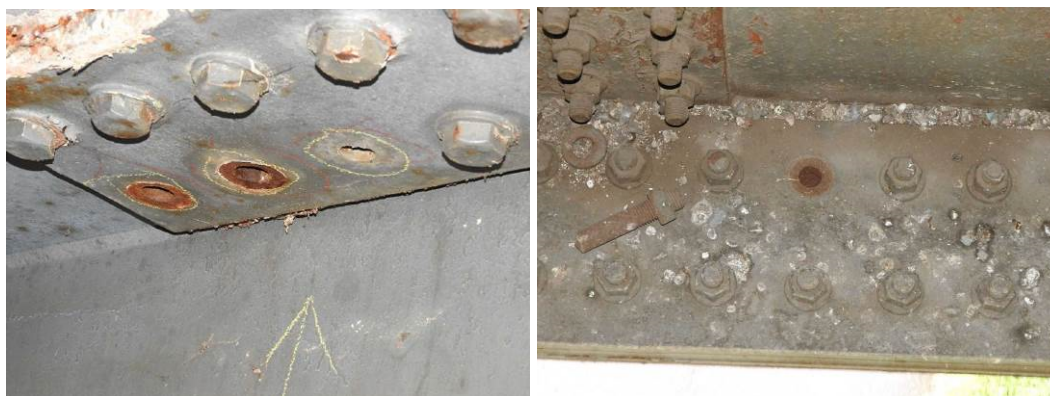
chybějící šrouby ve spoji
