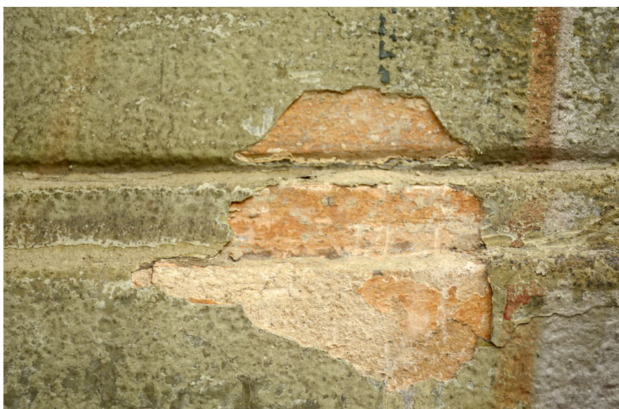
Detail vrstev barevných úprav v Z části S průčelí.
