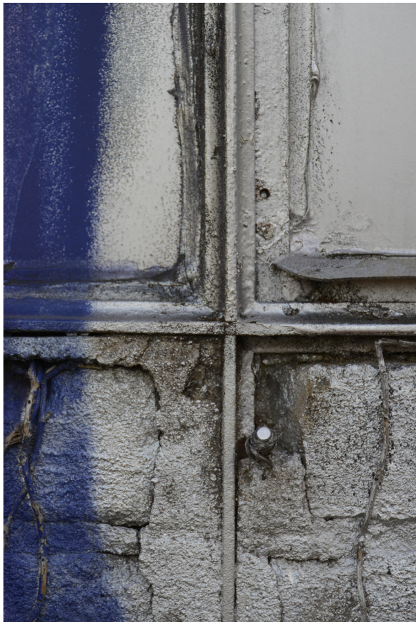
Detail kovové konstrukce okenní výplně Z průčelí.
