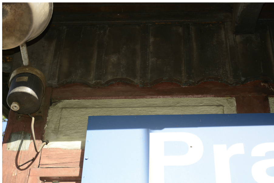
Detail zazdívky se zachovanými omítkami a členěním v podobě obdélného zrcadla nad oknem J průčelí.
