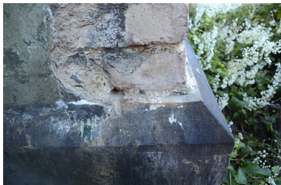
Detail kamenického opracování horní části soklu SV nároží.
